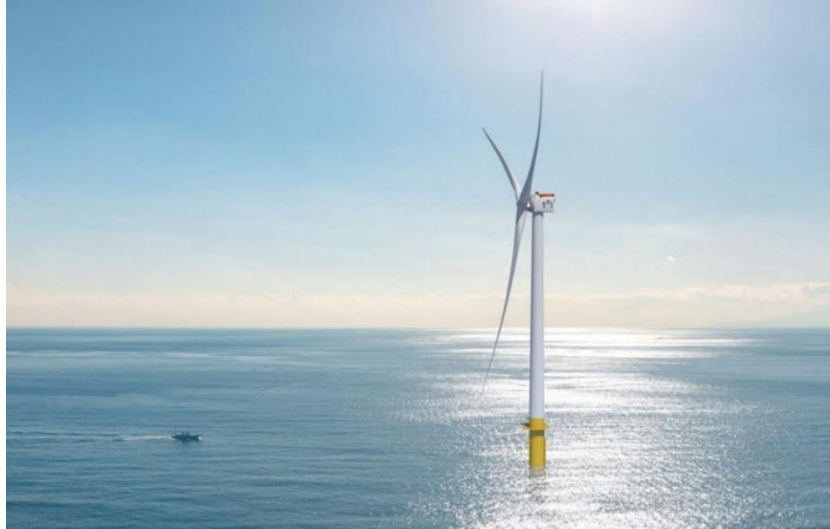
Figura A.1. Aerogenerador de eje horizontal de gran escala (Las longitudes aproximadas de la torre y de cada álabe son 270 y 90 metros, respectivamente) (Kaldellis & Boulogiorgou, 2022).
