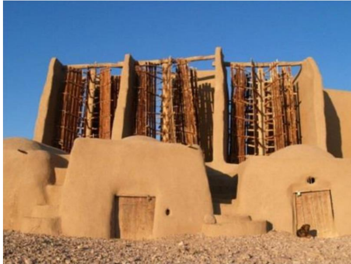
Figura 2.6. Molino de viento en Nashtifan, Irán. Características: 6 palas, longitud 15 m y diámetro del rotor de 7 m (Wendler-Ernst, 2014).
