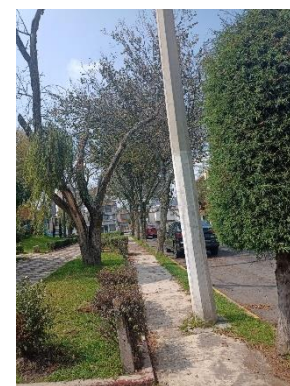
Figura 123. Pavimento de concreto en los alrededores
