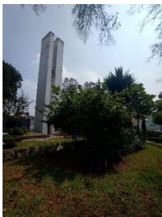
Figura 137. Tanque de agua elevado
