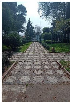
Figura 120. Cambio en material de pavimento
