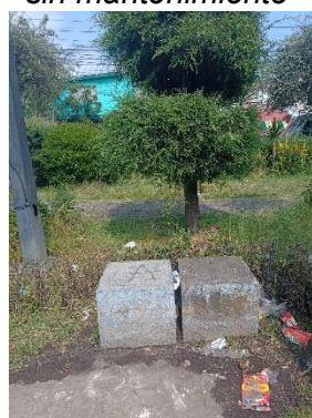
Figura 150. Bancos de concreto sin mantenimiento
