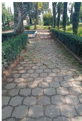
Figura 121. Pavimento de adoquín
