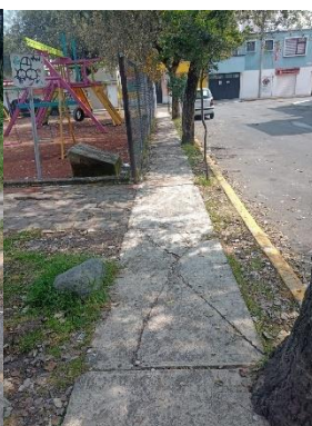
Figura 160. Levantamiento de banqueta por raíz de árbol
