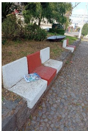
Figura 122. Piedra de río en pavimento
