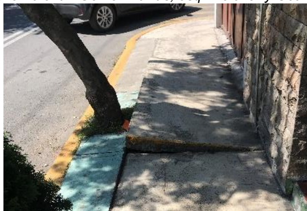
Figura 37. Calle Valentín Gómez Farías, esq. Melchor y Ocampo
