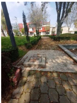
Figura 132. Registro de agua elevado
