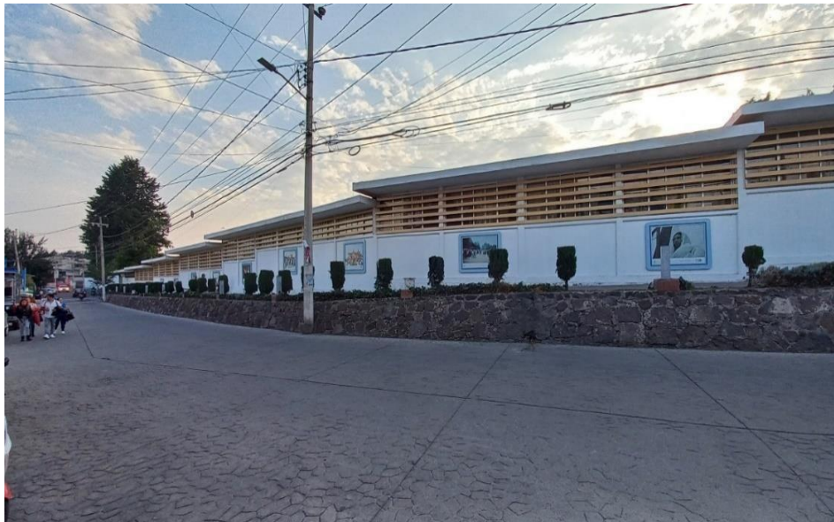
Ilustración 27 Banqueta elevada (andador)
