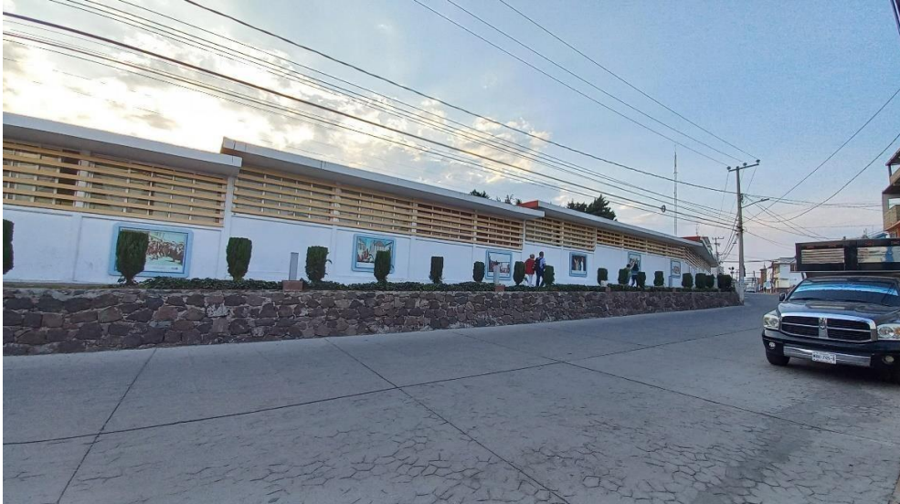
Ilustración 47 Materiales de pavimentación
