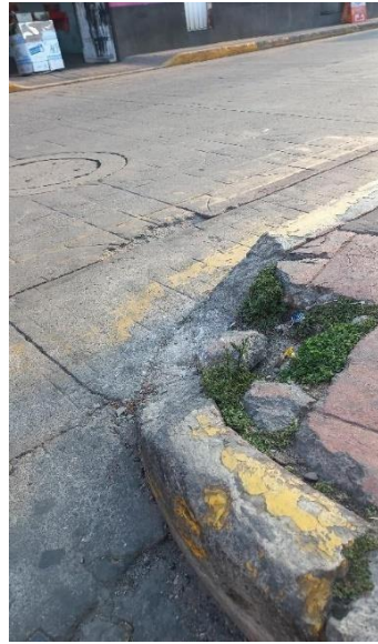
Ilustración 44 Fractura de banqueteta
