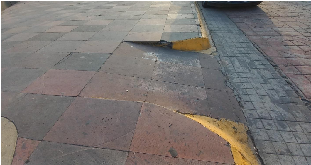
Ilustración 36 2da Rampa acceso a la Plaza Cívica
