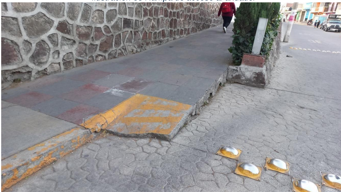
Ilustración 38 Rampa de acceso al andador
