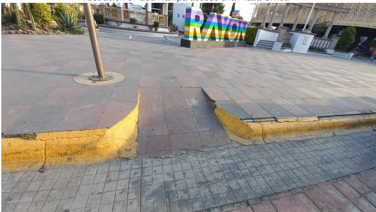
Ilustración 37 2da Rampa acceso a la Plaza Cívica
