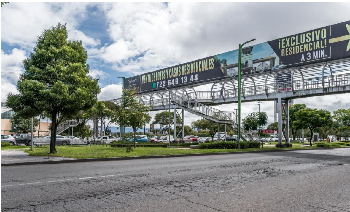
Figura 34. Puentes peatonales a la altura del Centro Comercial Galerías Metepec y del supermercado Walmart
