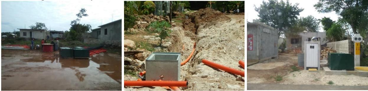
Imágenes 10, 11 y 12. Obras de la red eléctrica en la colonia “Mártires Antorchistas
