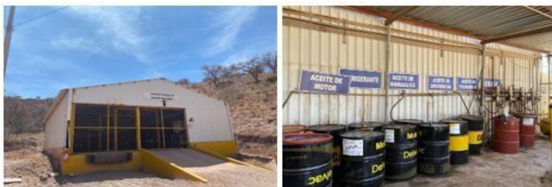
Figura 28. Almacén de Residuos Peligrosos.
