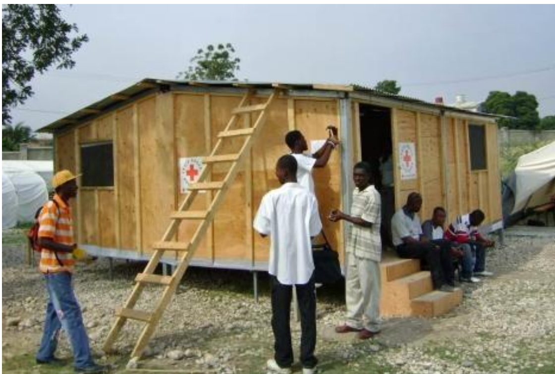
Imagen 19. Vivienda Progresiva en Haití, 2010.
