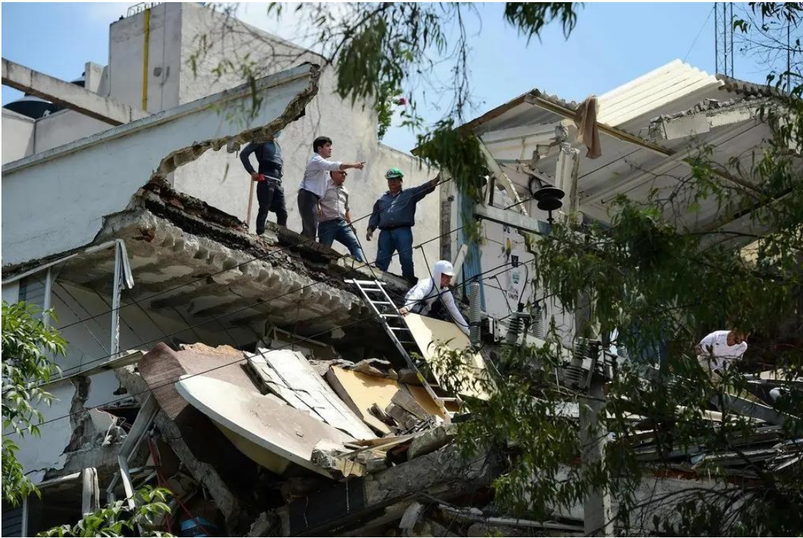
Imagen 28. "Edificio Colapsado, Ciudad de México, 2017".
