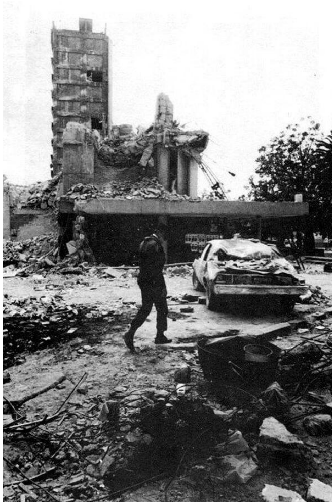
Imagen 26. “Edificios colapsados del Multifamiliar presidente Juárez, Ciudad de México, 1985”
