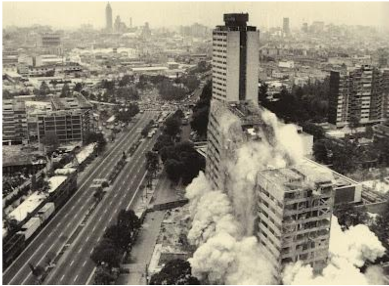
Imagen 24. "Edificio Nuevo León del Conjunto Nonoalco-Tlatelolco colapsado, Ciudad de México, 1985".
