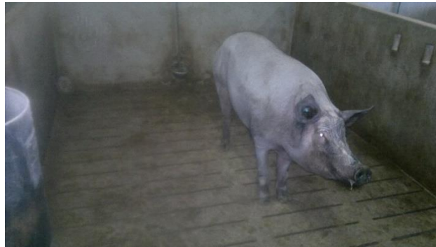
Figura 28. Corral para Semental, con slat de hormigón y separación cerrada. (Álvaro, 2016)
