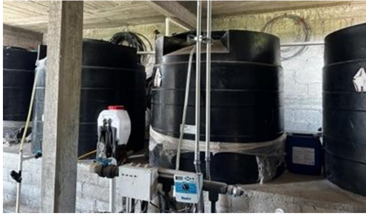
Figura 3.6: Fotografía de tinacos de almacenamiento para el fertirriego
