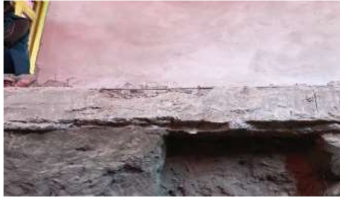
Imagen 8. Inspección de suelo del Torreón Fuente: Arq. Karina López García
