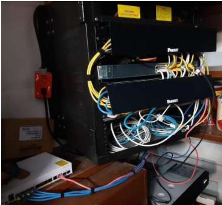
Imagen 6. IDF antes de reacomodar. Fuente: Elaboración propia
