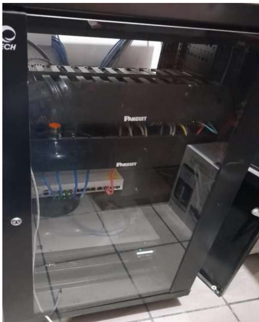
Imagen 9. IDF después de reacomodar. Fuente: Elaboración propia
