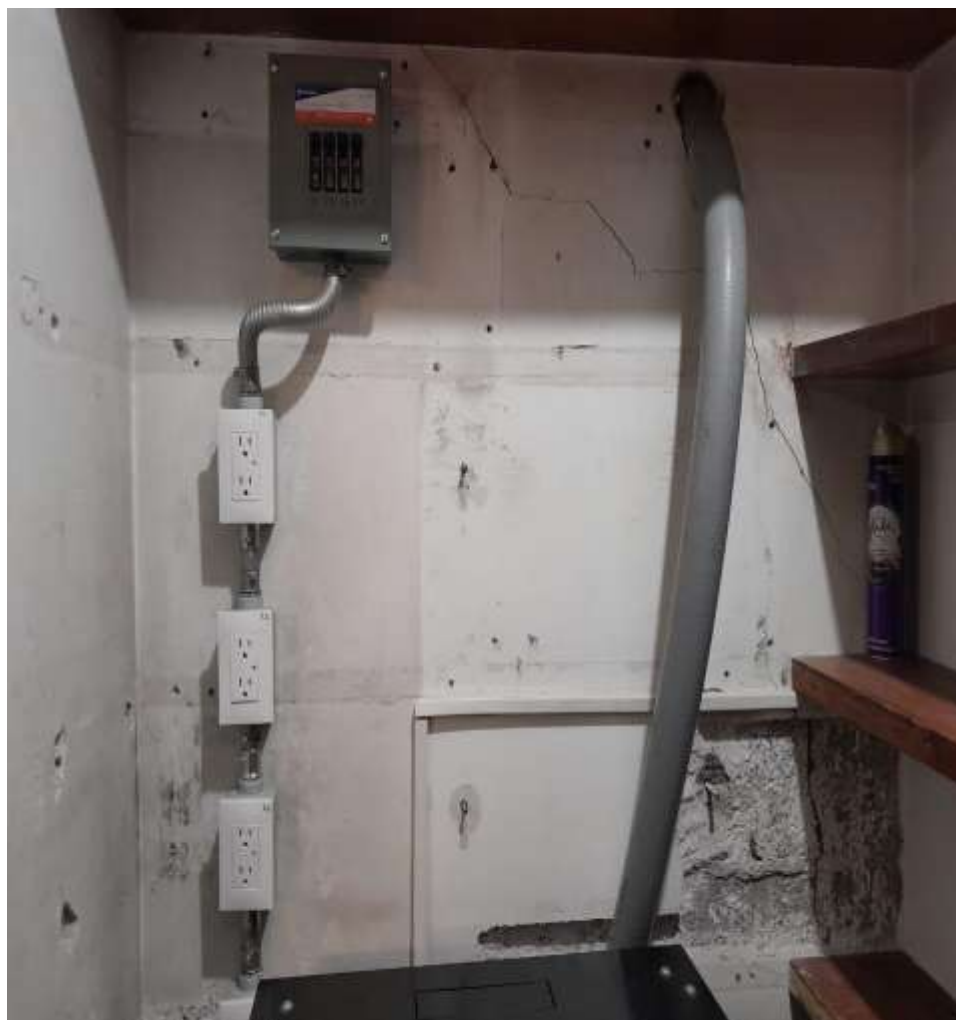
Imagen 8. IDF después de reacomodar. Fuente: Elaboración propia
