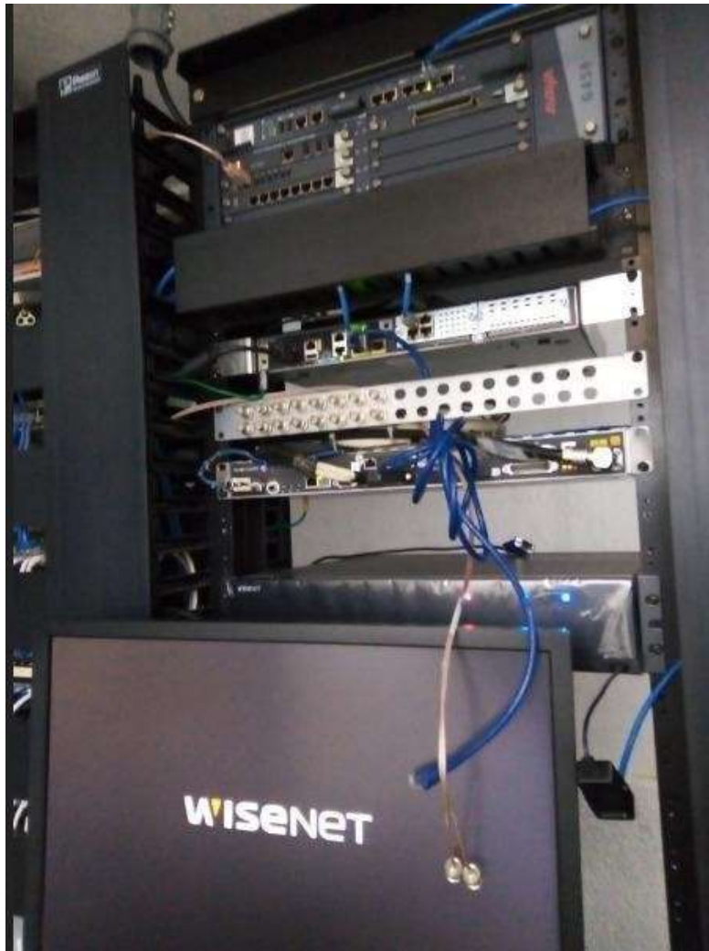
Imagen 10. IDF Site Principal, antes del reacomodo. Fuente: Elaboración propia
