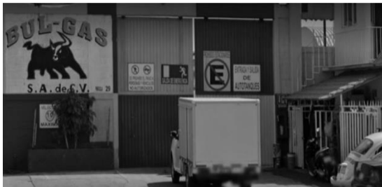
Imagen 1 .Entrada general a la Empresa Bulgas S.A. de C.V.
