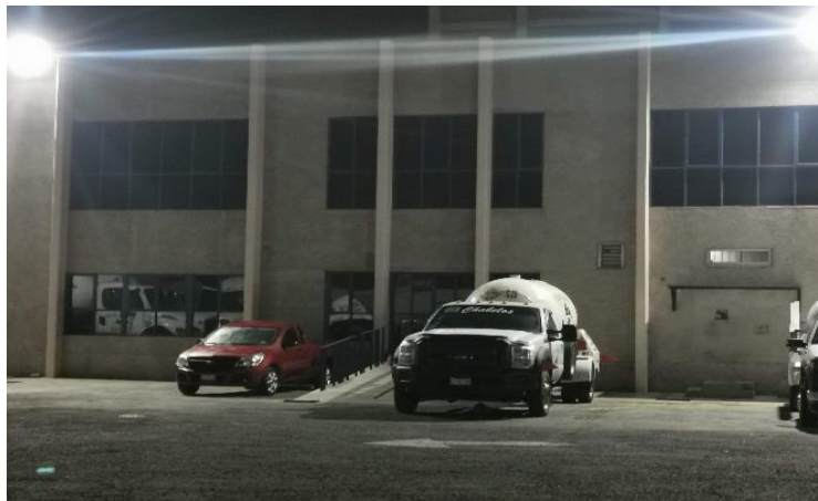
Imagen 12. Área de oficinas.
