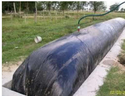
Figura 12 Biodigestor de flujo continuo
