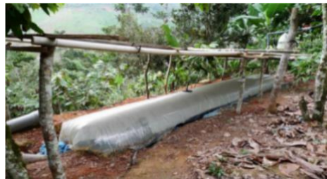
Figura 4 Biodigestor tubular Fuente: (Martí 2021).
