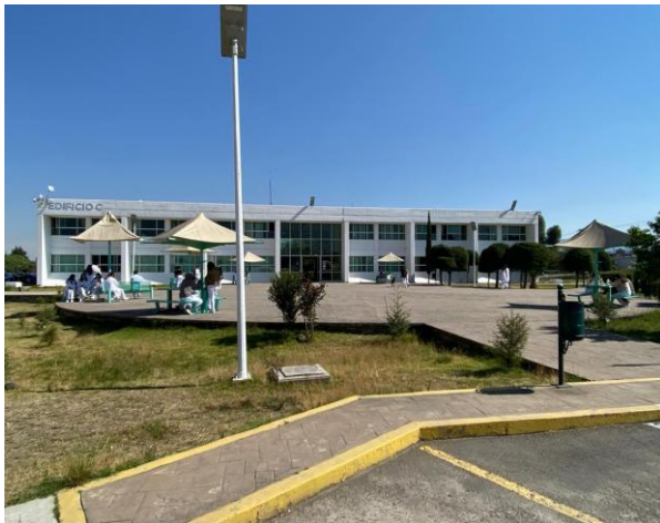
Imagen fotográfica 24| Edificio C
