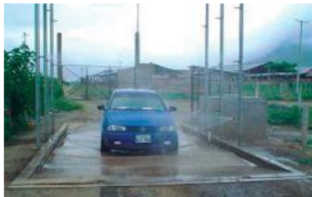
Figura 26. Arco con vado a la entrada de la granja porcina (Villagomez, 2023).
