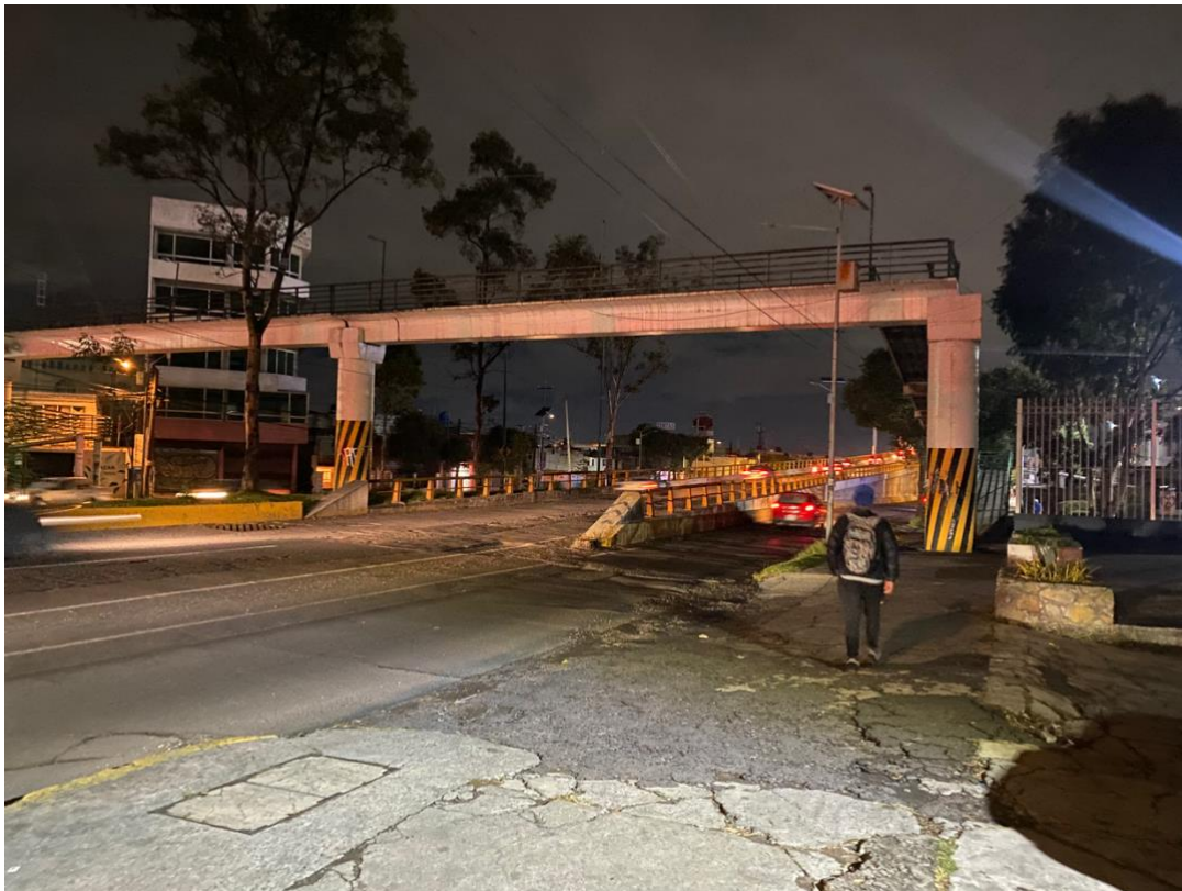
Figura 4. Banqueta principal en mal estado frente a la Fa.Ci.CO.
