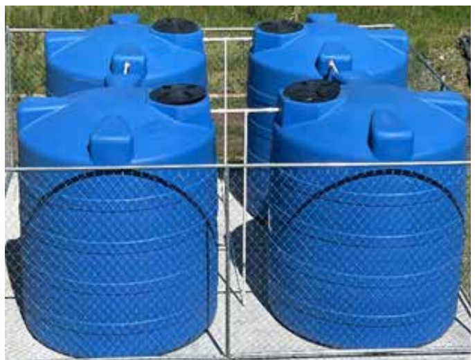
Figura 4. Cisternas de almacenamiento. Elaboración propia.
