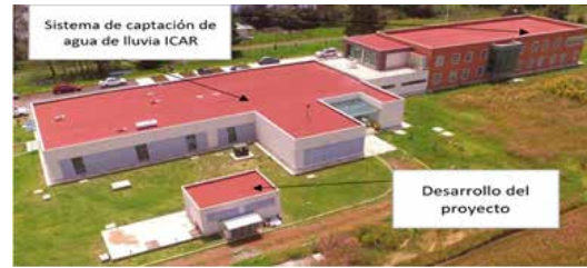
Figura 1. Superficie de captación 2000 m 2 . Elaboración propia.
