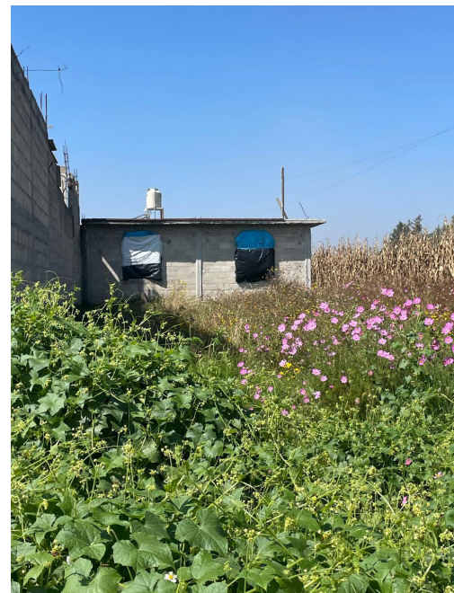
Figura 03 Viviendas en etapa inicial
