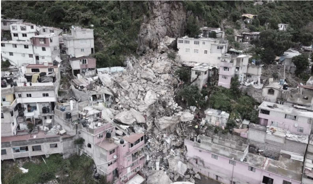
Figura 1. Caída de rocas en el cerro del Chiquihuite, Tlalnepantla, Estado de México.
