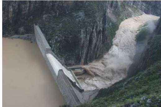
Figura 2 Vista aérea de la presa rompepicos tres días después del huracán Alex 2010.
