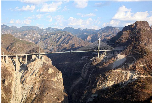
Figura 5 El Puente Atirantado más alto del mundo
