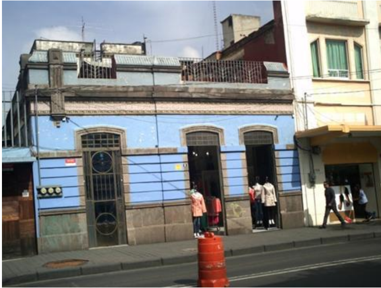
Figura -10 Av. Juárez entre Av. Hidalgo y Av. Independencia. Este inmueble se resistió al cambio impuesto por el H. Ayuntamiento
