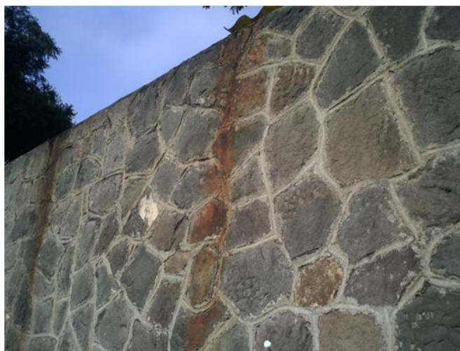
Figura 176 Agua Meteórica descendente A. Jesús Carranza Toluca Méx.
