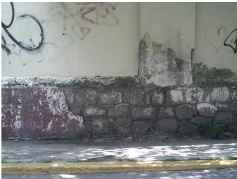
Figura 172 Muro de la barda perimetral de La Tabacalera parte baja
