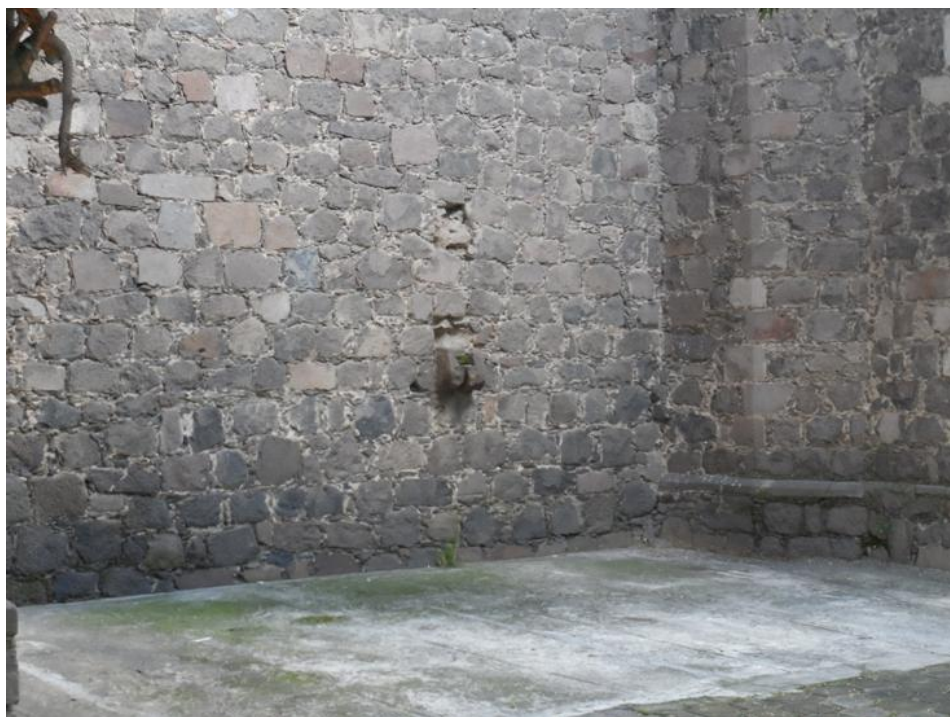
Figura 285 Ambiente que rodea a la Iglesia
