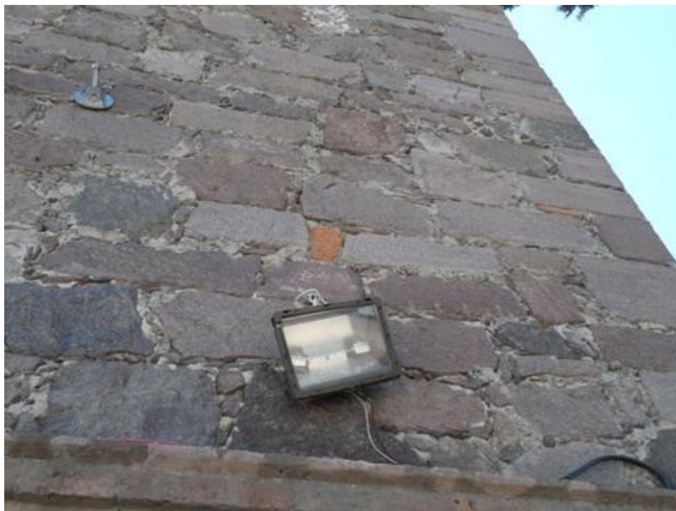
Figura 297 Intervenciones inadecuadas
