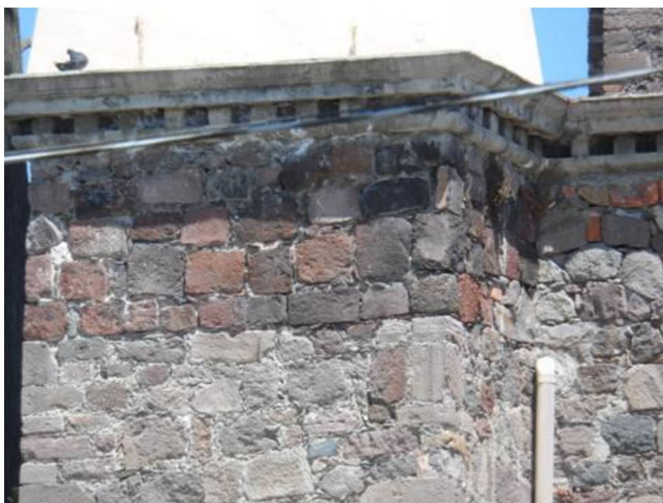
Figura 294 Delimitación de intervenciones en los muros
