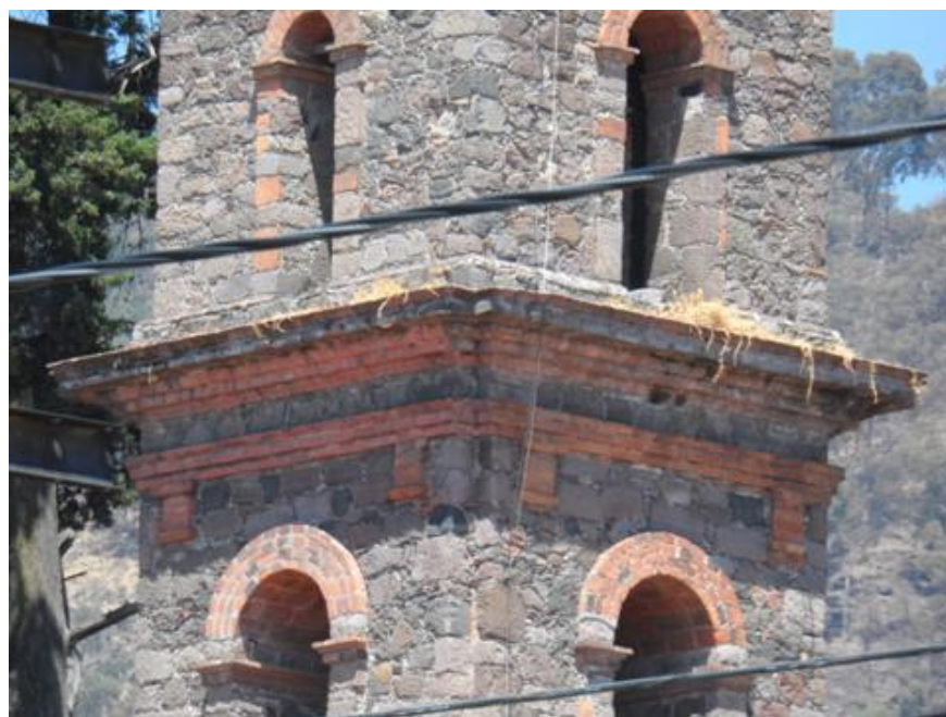
Figura 292 Detalle del acomodo de piedra basáltica
