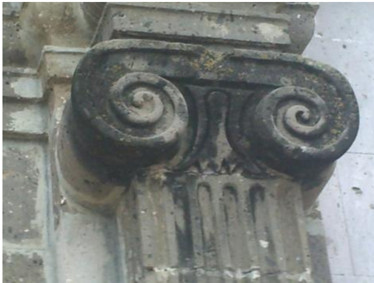
Figura 55 Columna Jónica, fachada de la Iglesia de la Asunción en Tlapacoyan Veracruz. ( Scytonema , que tiene una textura de terciopelo y solo crece en la superficie).
