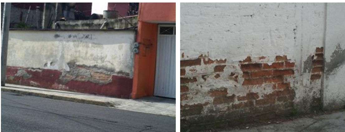
Figura 42 Estratigrafía de fachadas recientes
