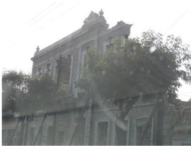
Figura -48 Estado actual
