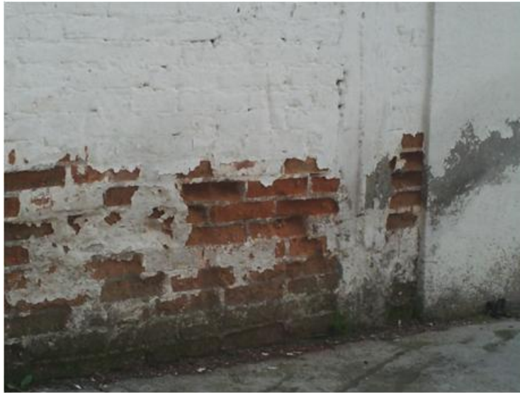
Figura 149 Disolución de los tabiques rojos. Cavidades que se van formando.
