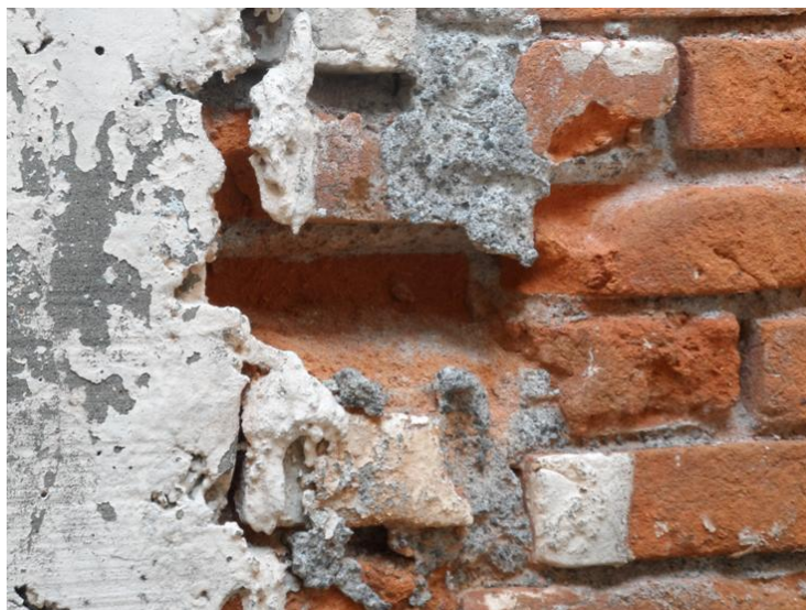
Figura 3 Aquí se presenta la condición contraria a la Figura anterior, ladrillos están cerca de un castillo de concreto lo que ocasiona que la porosidad sea diferente y por lo tanto el fenómeno de transporte de agua sea diferente en ambos materiales.
