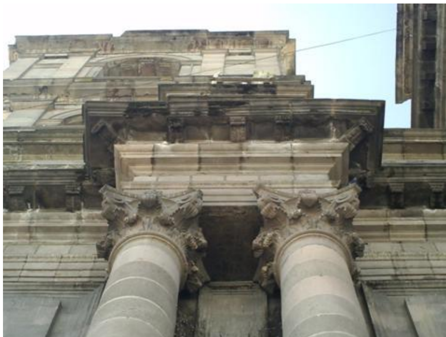
Figura 243 Columnas de la Fachada
