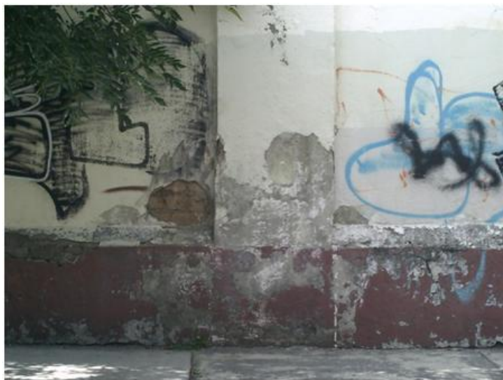
Figura 173 Muro de la barda perimetral de La Tabacalera parte media
