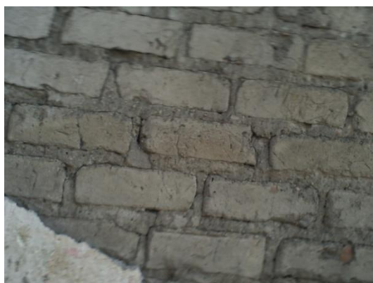
Figura 170 Muro de Adobe. Centro Histórico de Toluca. Av. Constituyentes Pte.
