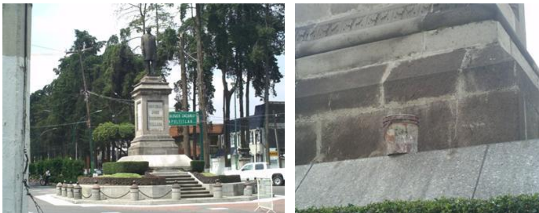
Figura 35. Av Villada y el principio de Paseo Colón
