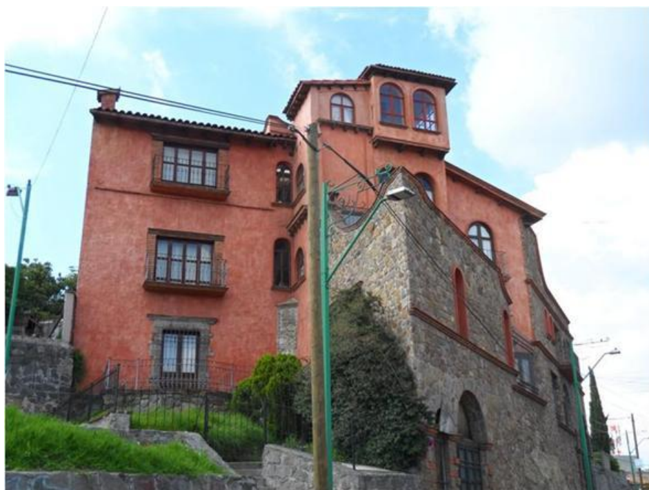
Figura 148. Casa en Av. Gómez Pedraza. Diferentes materiales de construcción.
