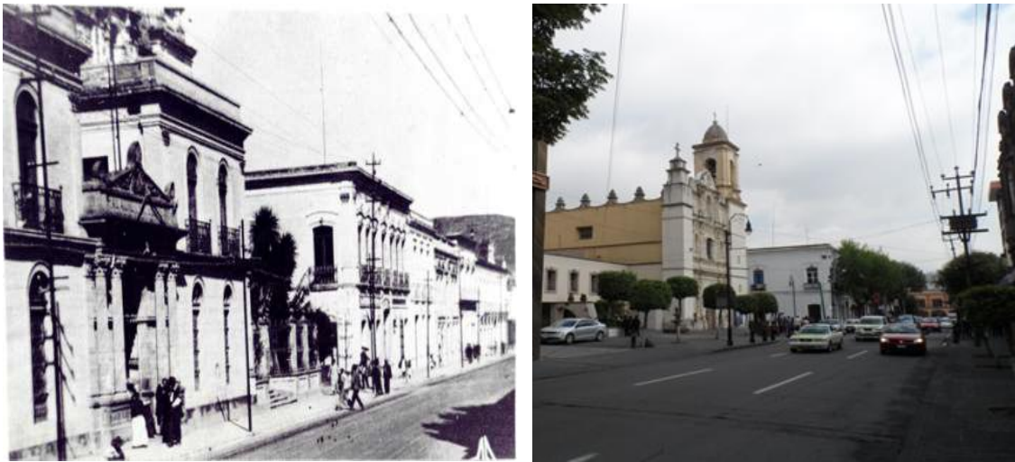
Figura -27 Av. Villada acera poniente
