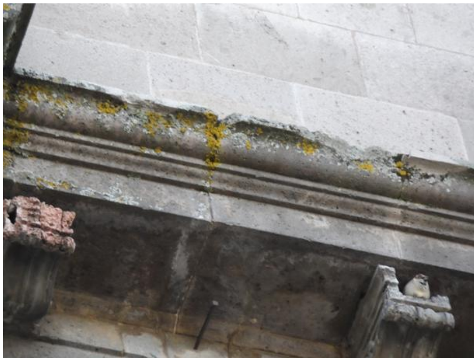
Figura 270 Destrucción del material pétreo
