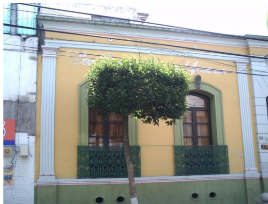
Figura 177 Obstrucción de agua Calle Aldama Toluca Méx.
