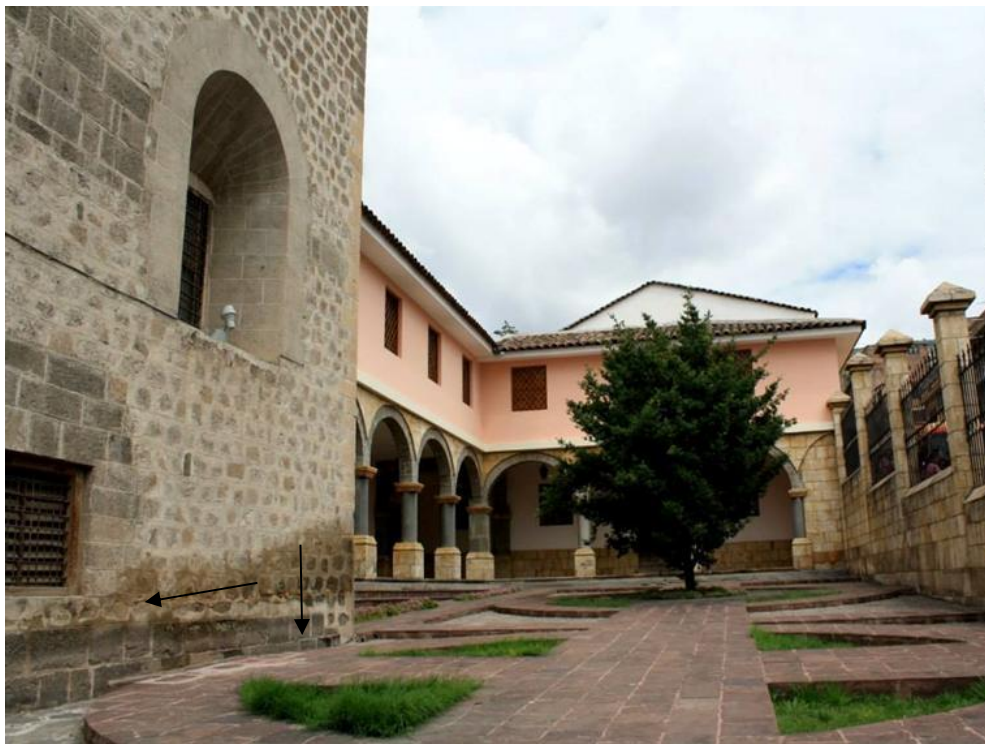
Figura 145 Recinto anexo a la Catedral de Santiago de Compostela (Eduardo Montes)
