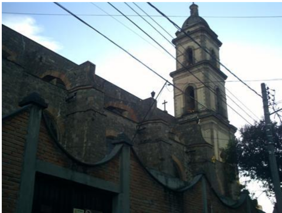
Figura 258 Pared lateral norte
