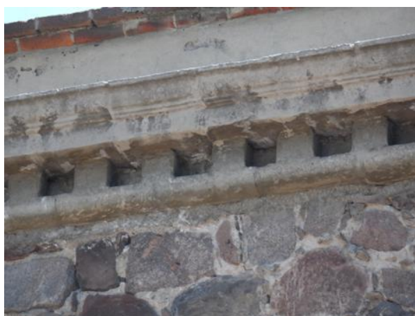
Figura 298 Deterioro de la fachada
