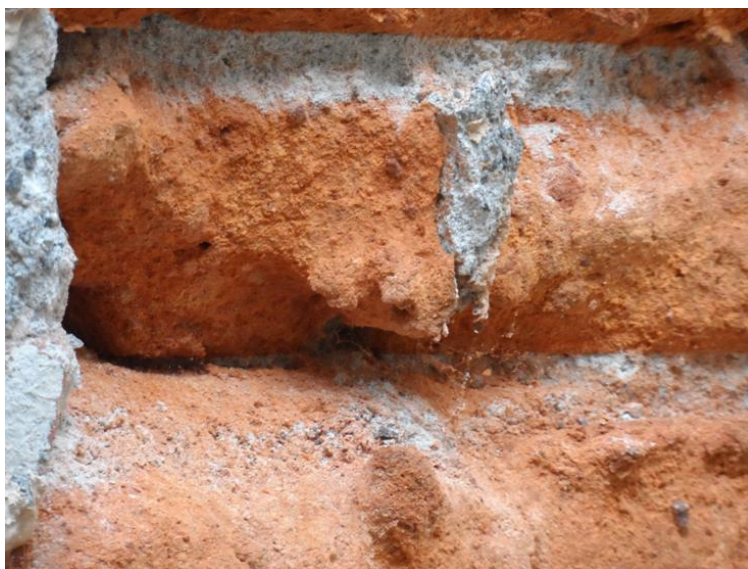
Figura 4 Aquí el desgaste es similar prevaleciendo el proceso de arenización que es una disgregación de los materiales.
