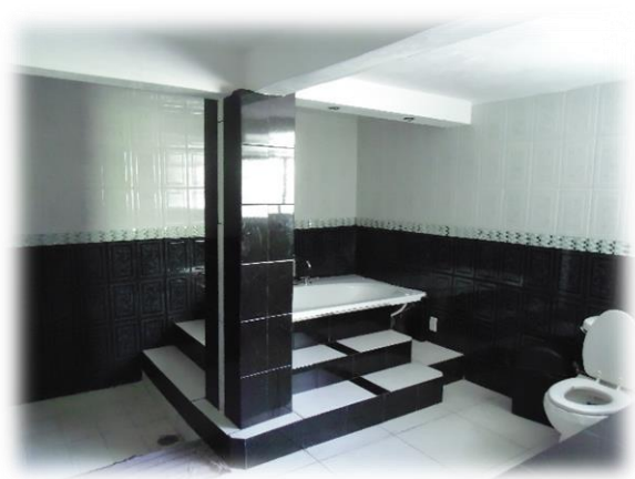
Ilustración 46 Reformas en el baño
