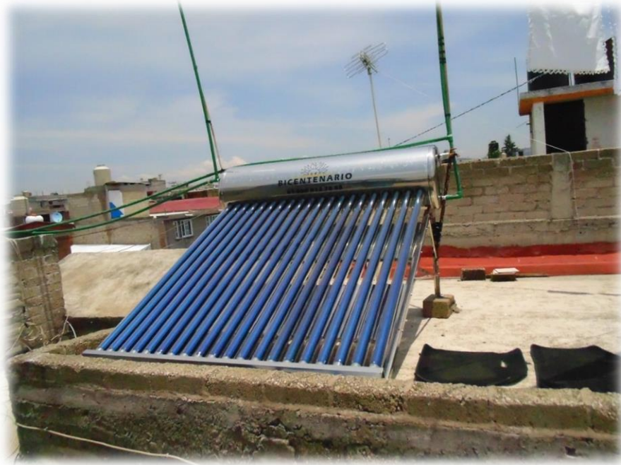
Ilustración 45 Colector solar térmico
