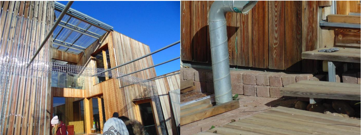
Ilustración 25 Fachada Casa Lleyda
