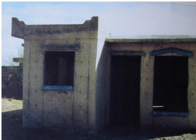
Ilustración 3: Vivienda en obra negra
