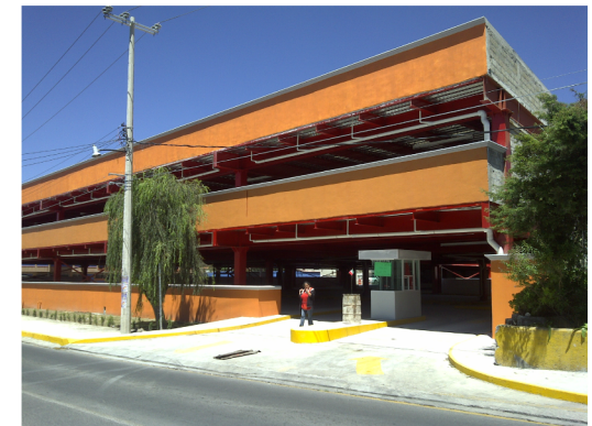
Estacionamiento Municipal, Tepotzotlán, México. (Fotos de archivo de la empresa JICO) ▲
