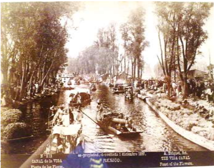
Fotografía 1: “Canal de la Viga”
