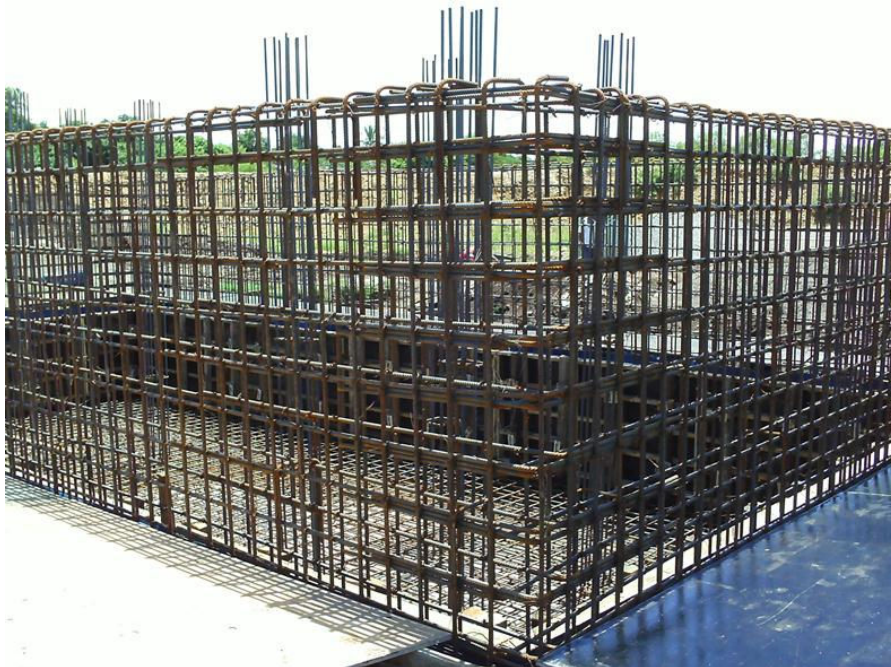
Obsérvese: armado de muros con acero de refuerzo de f_y = 4200 \text{ kg/cm}^2 del # 5 con separación a cada 20 cm en sentido horizontal y 20 cm en sentido vertical en dos lechos para el digester de lodos. Armado de columnas con 6 varillas del #6 y estribos del #3 a cada 15 cm.
