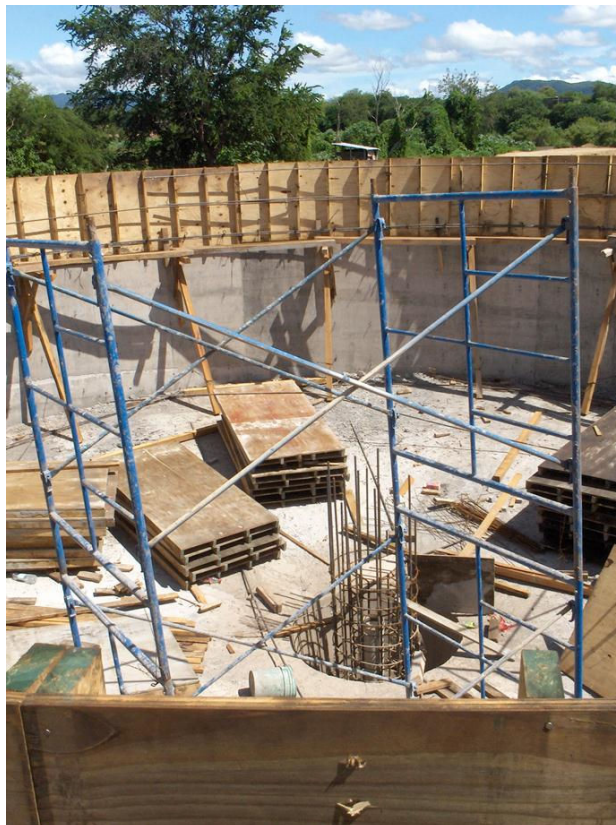
Obsérvese: Avance de la estructura del sedimentador primario donde se esta realizando el cimbrado interior con madera de triplay de 19 mm de espesor la obra falsa y los andamios utilizados durante la ejecución de los trabajos
