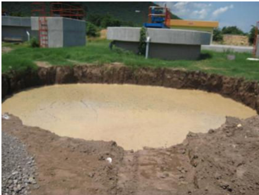
Obsérvese: Excavación en material denominado grava-arena en presencia de agua a 2.00 m de profundidad para desplante del espesor de lodos.
