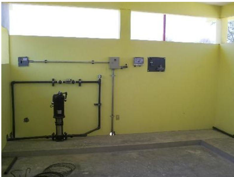
Obsérvese: muro de la caseta de cloración, donde quedan anclados los equipos; bomba de ayuda, dosificador de cloro y regulador de cloro, tuberías eléctricas de alimentación y tuberías de inyección de gas cloro que irán al tanque de contacto de cloro
