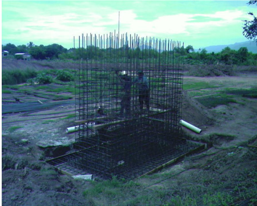
Obsérvese: Avance de la estructura caja distribuidora No 2 armada con varillas f_y = 4200 \text{ kg/cm}^2 del # 4 a cada 15 cm en ambos sentidos en dos lechos vertical y horizontal.
