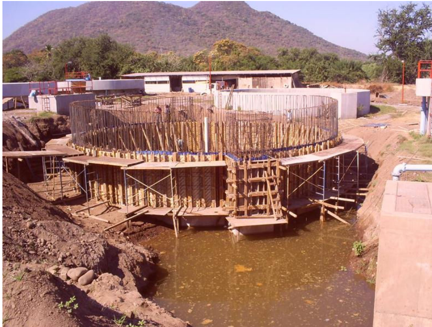
Obsérvese: Avance de la construcción del filtro rociador, cimbra de contacto interior y exterior con madera con triplay de 19 mm de espesor en muros a una altura de 4.88 m con respecto al nivel de desplante, obra falsa y andamiaje, banda de pvc de 152 mm (6") de ancho que actúa como junta fría para evitar fugas al realizar el siguiente colado, presencia de agua del nivel freático.
