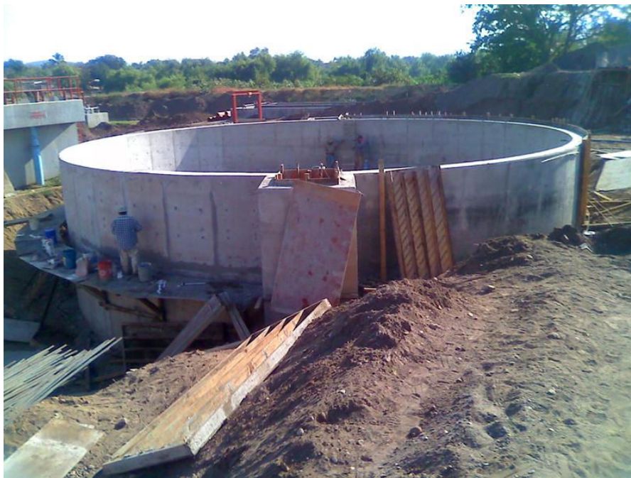
Obsérvese: Obra civil del filtro rociador terminada caja de ventilación natural para la oxigenación de bacterias, retiro de cimbra de contacto
