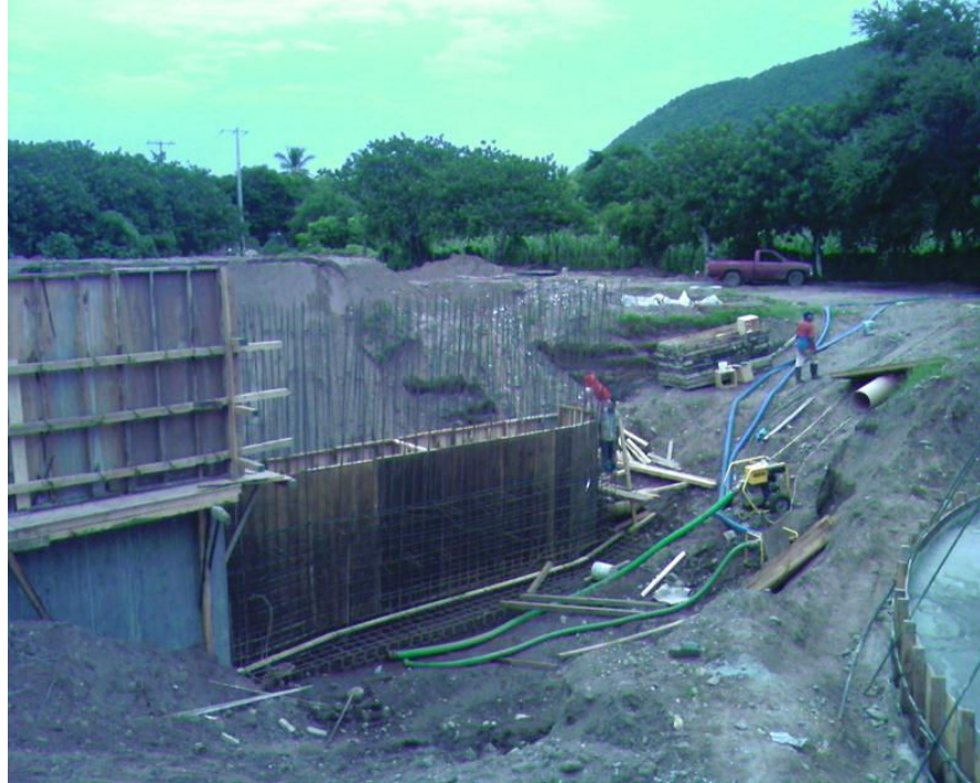
Obsérvese: Avance de la construcción de las estructuras de cárcamo de bombeo de aguas crudas y pretratamiento armado con varillas f_y = 4200 \text{ kg/cm}^2 del # 4, cimbra de madera de triplay de 19 mm de espesor en la cara exterior del cárcamo y cara interior del pretratamiento, así como los equipos de bombeo de 102 mm (4") y 76 mm (3") de diámetro de descarga para desalajo del agua del nivel freático.
