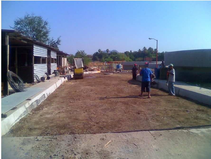
Obsérvese: construcción de guarniciones, banquetas y relleno de caja con material de banco tepetate con la humedad optima colocada en capas de 20 cm y compactada al 95% de la prueba proctor estándar con rodillo vibratorio y afine de la superficie con herramienta menor.
