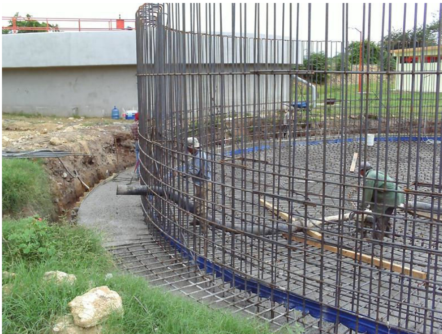
Obsérvese: colado de losa de cimentación una vez colocado el acero de refuerzo f_y = 4200 \text{ kg/cm}^2 del # 6 y la banda de pvc de 152 mm (6") de ancho, armados de cimentación con separación 16 cm perimetralmente y a 21 cm radialmente, muros en el sentido vertical a cada 20 cm y en sentido horizontal a cada 25 cm de separación en dos lechos.
