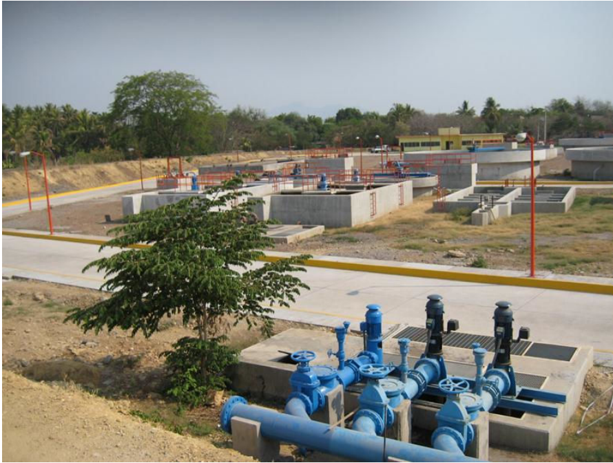
Obsérvese: Estructuras de proceso terminadas: Edificio de operación, sedimentador secundario, cajas distribuidoras, espesadores de lodos, digestores de lodos, tanque de contacto de cloro, alumbrado exterior, vialidad de concreto hidráulico, bordo perimetral y cárcamo de agua tratada equipado con bombas verticales, piezas especiales y múltiple de descarga al río Cutzamala de la PTAR.
