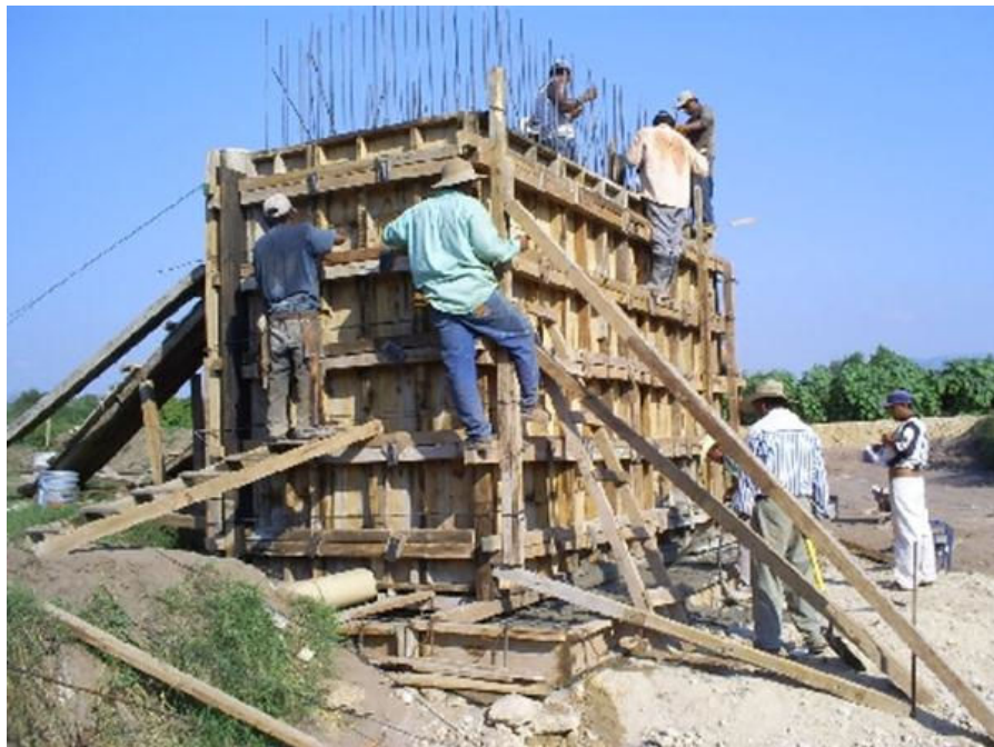
Obsérvese: Avance de la caja distribuidora No 5, habilitando cimbra de madera de triplay de 19 mm de espesor rigidizada con barrotes en el sentido vertical y en el sentido horizontal con moños y polines con dimensiones de 0.10 \times 0.10 \times 3.05 \text{ m}
