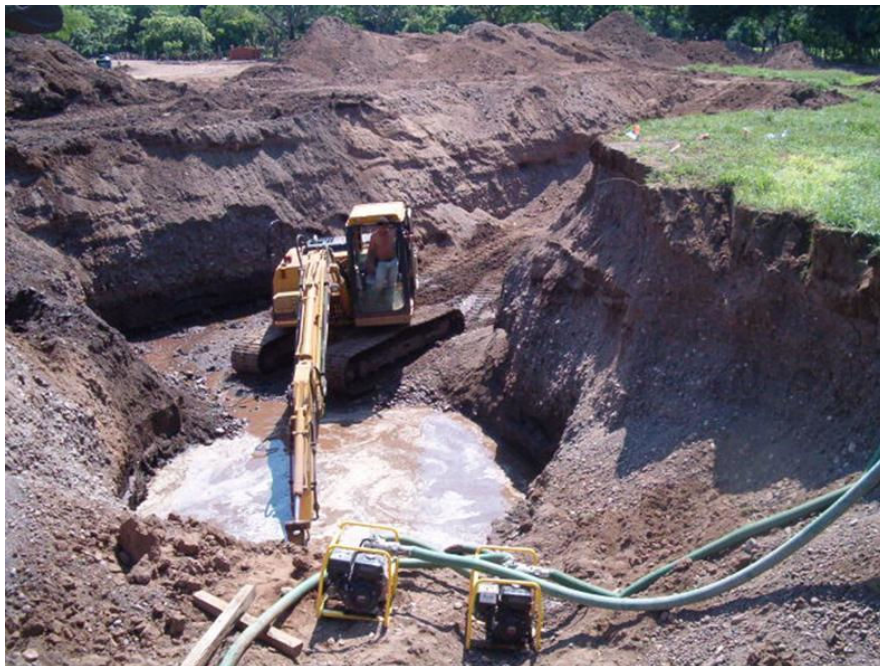
Obsérvese: Excavación del material denominado grava-arena a cielo abierto con maquinaria pesada en presencia de agua para el desplante de las estructuras de pretratamiento y cárcamo de aguas crudas, y los equipos de bombeo de achique de 76 mm (3") de diámetro para el desalojo del agua freática.
