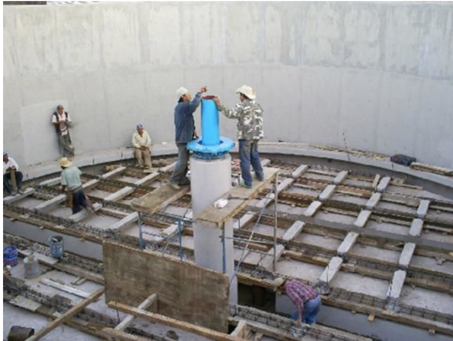
Obsérvese: Construcción del falso fondo para sostener el medio filtrante armado con varillas f_y = 4200 \text{ kg/cm}^2 del # 4 en columnas y trabes, así mismo se inicia con el montaje del equipo mecánico del filtro rociador.
