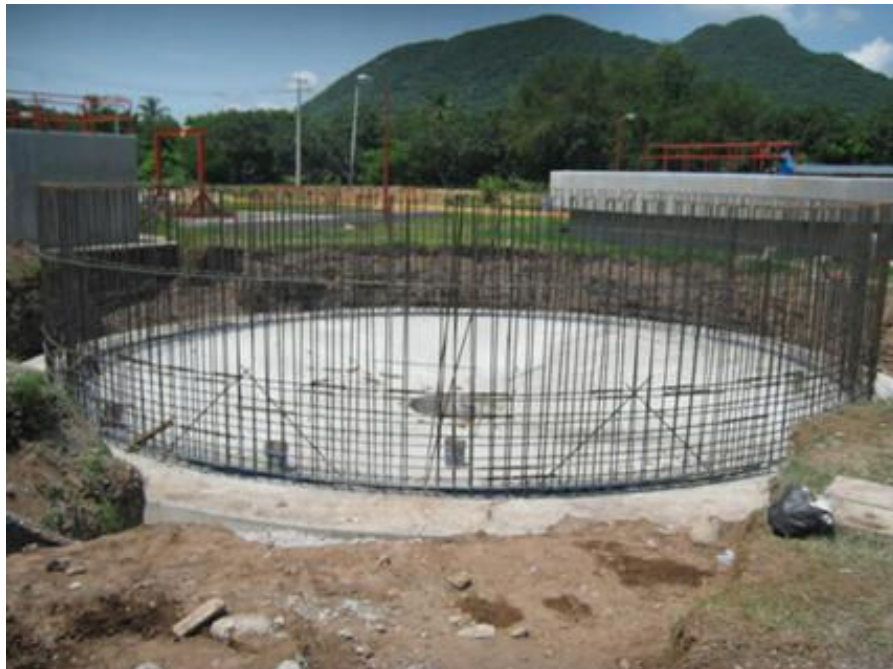
Obsérvese: Losa de cimentación con acero de refuerzo f_y = 4200 \text{ kg/cm}^2 del # 6, los armados en la cimentación con separación 16 cm perimetralmente y a 21 cm radialmente en dos lechos, armado de muros en el sentido vertical a cada 20 cm y en sentido horizontal a cada 25 cm de separación en ambos lechos.
