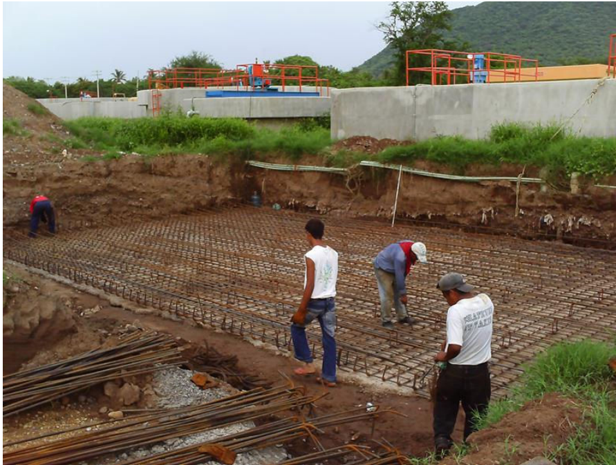
Obsérvese: Plantilla de terminada de concreto simple hecho en obra de f_c = 100 \text{ kg/cm}^2 colocación de acero de refuerzo de f_y = 4200 \text{ kg/cm}^2 del # 5 con separación a cada 20 cm en sentido longitudinal y 15 cm en sentido transversal en losa de cimentación en dos lechos para el digester de lodos.
