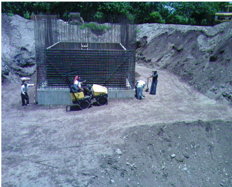
Obsérvese: Avance del cárcamo de Bombeo de aguas crudas hasta 4.88 m de altura con respecto al nivel desplante, preparando el armado con varillas f'y = 4200 \text{ kg/cm}^2 del # 5, y la compactación al 60% de la prueba proctor estándar con material producto de la excavación con rodillo vibratorio.
