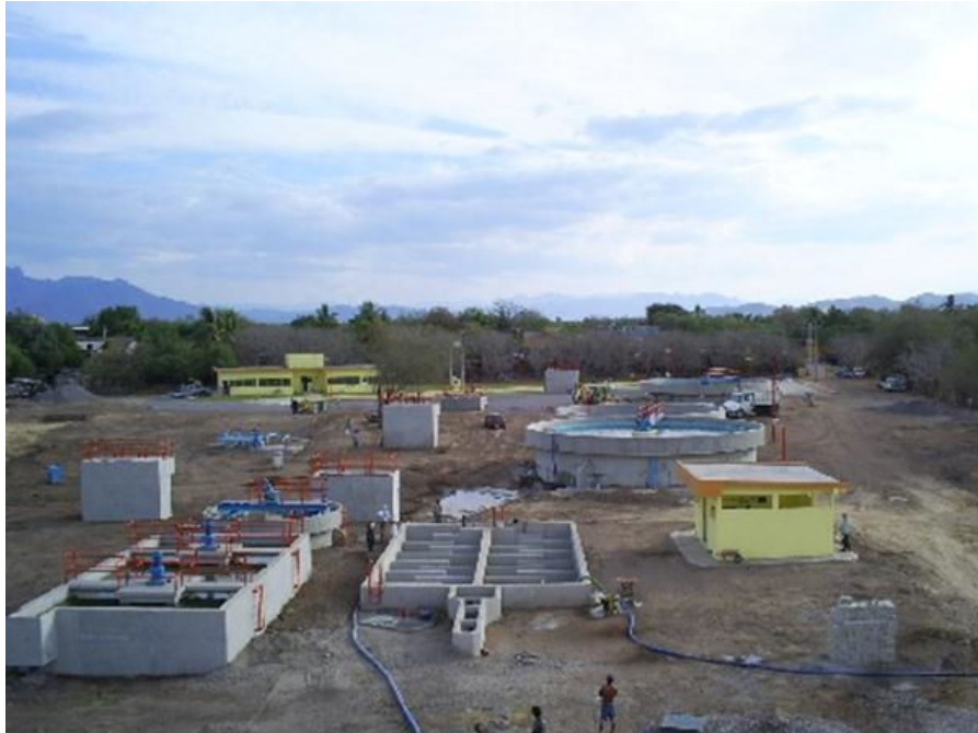
Obsérvese: Estructuras terminadas con montajes de mecanismos para el proceso de filtros rociadores, edificio de operación, caseta de cloración, cajas distribuidoras, sedimentadores primario y secundario, cárcamo de recirculación, espesador de lodos, digestor de lodos, tanque de contacto de cloro y estructura para medidor parshall de la PTAR.
