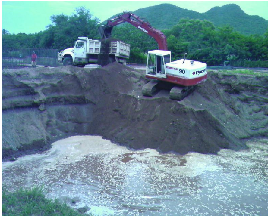
Obsérvese: Excavación del material denominado grava-arena a cielo abierto con maquinaria pesada en presencia de agua para el desplante de la estructura de Filtro rociador así como la carga del material producto de la excavación para su retiro fuera de la obra.
