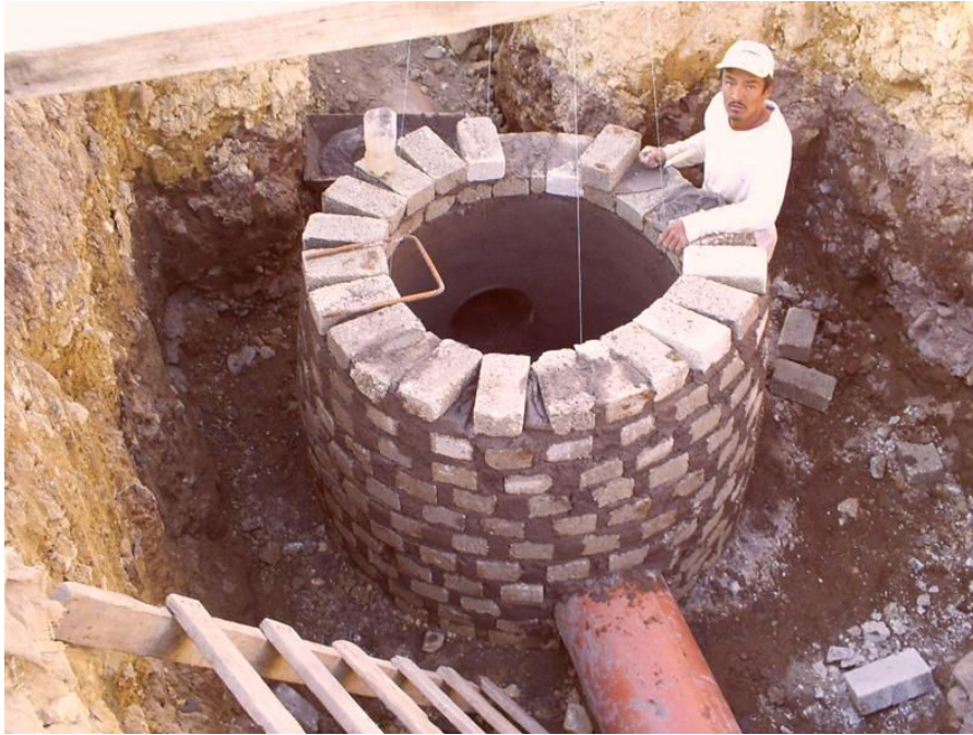
Obsérvese: Construcción de pozo de visita construido con tabicón con escalones a base de varilla de f_y = 4200 \text{ kg/cm}^2 del # 5 aplanado con mortero cemento arena 1:3.
