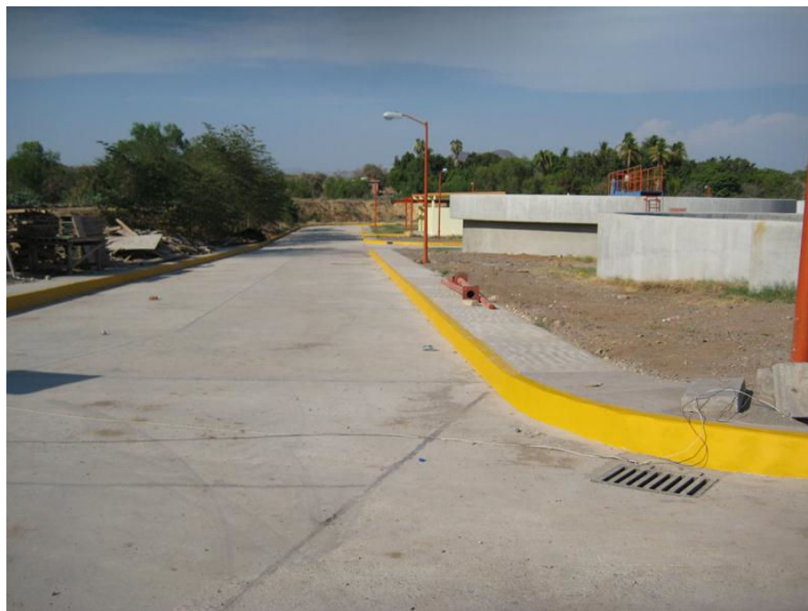
Obsérvese: Vialidad terminada, aplicación de pintura amarillo tráfico en guarniciones, alcantarilla de piso para alcantarillado pluvial, postes y luminarias de alumbrado exterior.
