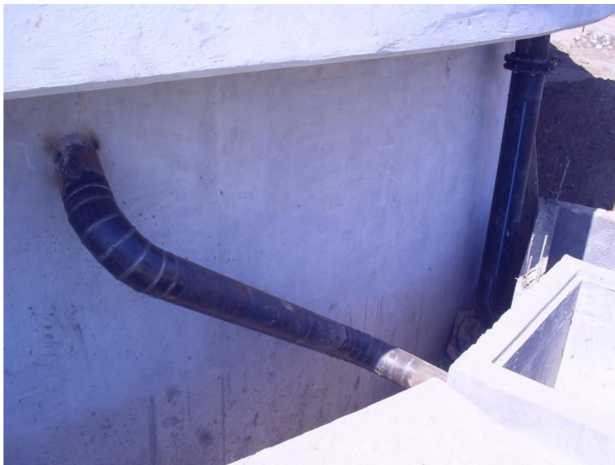
Obsérvese: trabajos de pailería en tubería de acero al carbón cedula 40 de 102 mm (4") de diámetro para descarga de caja de natas del sedimentador primario.
