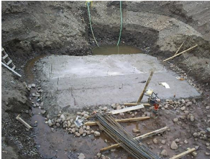
Obsérvese: Plantilla terminada del cárcamo de agua cruda hasta una profundidad de 7.80 m con respecto al nivel de terreno natural, conformada de piedra bola de 15 a 20 cm de diámetro cuyos huecos fueron cubiertos con mezcla de concreto en seco de f'c = 250 \text{ kg/cm}^2 en presencia de agua, en la parte posterior se encuentran trabajando los equipos de bombeo de achique de 76 mm (3") de diámetro para evitar la acumulación del agua freática en el área de trabajo
