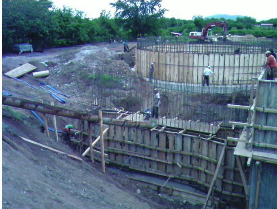
Obsérvese: Avance de la estructura del pretratamiento donde se esta realizando el colado de concreto de f'c = 250 \text{ kg/cm}^2 y cimbra interior y exterior de madera de triplay de 19 mm de espesor en pretratamiento y sedimentador primario troquelada con moños entre el triplay y los polines a fin de darle rigidez a la cimbra
