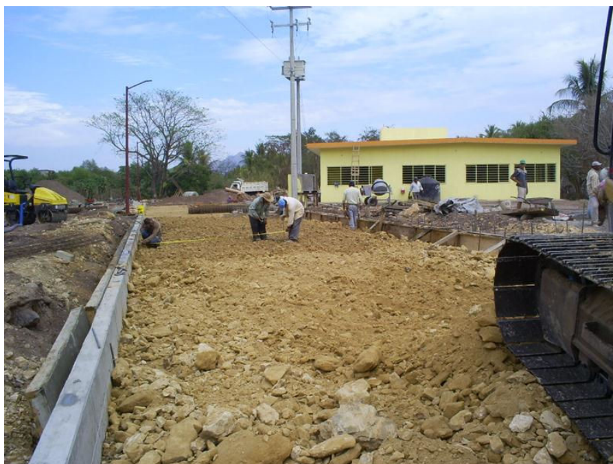
Obsérvese: el proceso de colocación y compactación del material denominado tepetate compactado al 95% de la prueba proctor estándar en capas de 20 cm para la conformación de una de las vialidades, guarniciones, subestación eléctrica tipo poste de 150 KVA y edificio de operación terminado de la PTAR.
