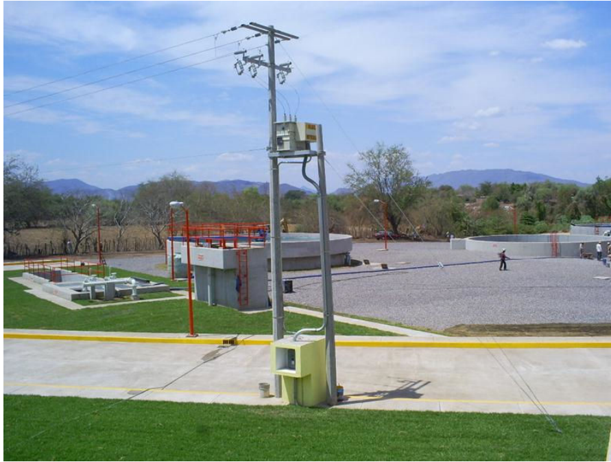
Obsérvese: Vista parcial de Jardinería, subestación eléctrica tipo poste de 150 KVA, nicho de medición e interruptor general, vialidad, banquetas y guarniciones, pretratamiento, cárcamo de bombeo de aguas crudas, caja distribuidora No 1 con barandales, sedimentador primario, filtro rociador de estructuras terminadas de la PTAR.
