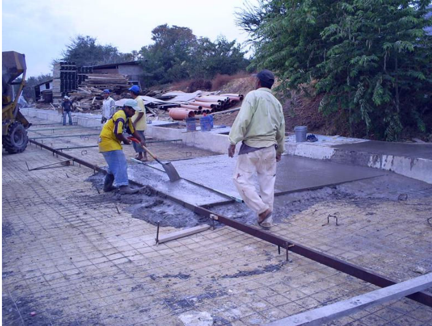
Obsérvese: malla colocada electrosoldada 6-6-10/10 de f_y = 50 \text{ kg/mm}^2 y colado de losas de concreto de 3.50 \times 3.50 \times 0.15 \text{ m} de espesor de f_c = 200 \text{ kg/cm}^2 con hormigonera autodosificante y colocación de cimbra tubular en la frontera central para seccionar las dimensiones de los cuadros que forman las losas de tránsito de la vialidad.
