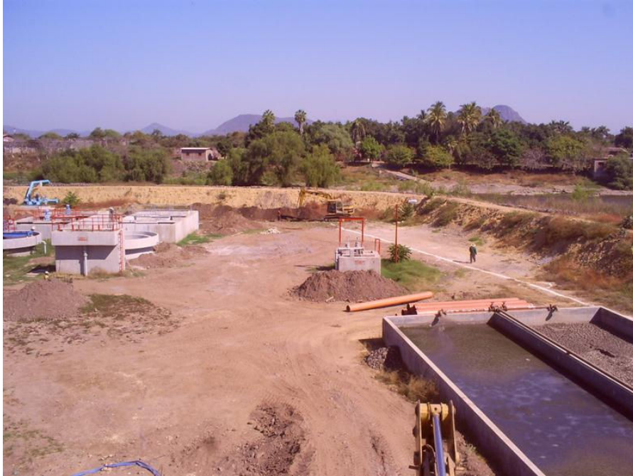
Obsérvese: Trazo y excavación de zanjas con maquinaria pesada para la instalación de tubería de tubería de pvc serie DI alcantarillado de 350 mm (14") de diámetro para el drenaje pluvial de la PTAR.
