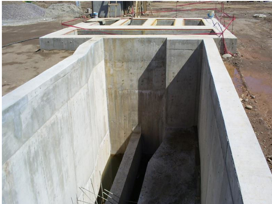
Obsérvese: Avance de las estructuras de Pretratamiento y cárcamo de aguas crudas construidas con concreto de f_c = 250 \text{ kg/cm}^2 armadas con acero de refuerzo f_y = 4200 \text{ kg/cm}^2 del # 4 y #5 respectivamente
