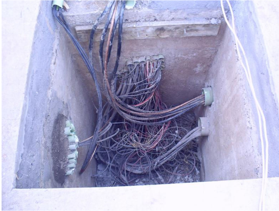
Obsérvese: Construcción de registro eléctrico para alojar tuberías de pvc eléctrico tipo pesado de diversos diámetro para alojar cables de diferentes calibres para fuerza, control, alumbrado exterior y energizar equipos de bombeo de diferentes capacidades y equipos de proceso, sedimentadores primarios y secundarios, espesador de lodos, digestor de lodos, caseta de cloración y medidor de flujo electrónico de la PTAR.
