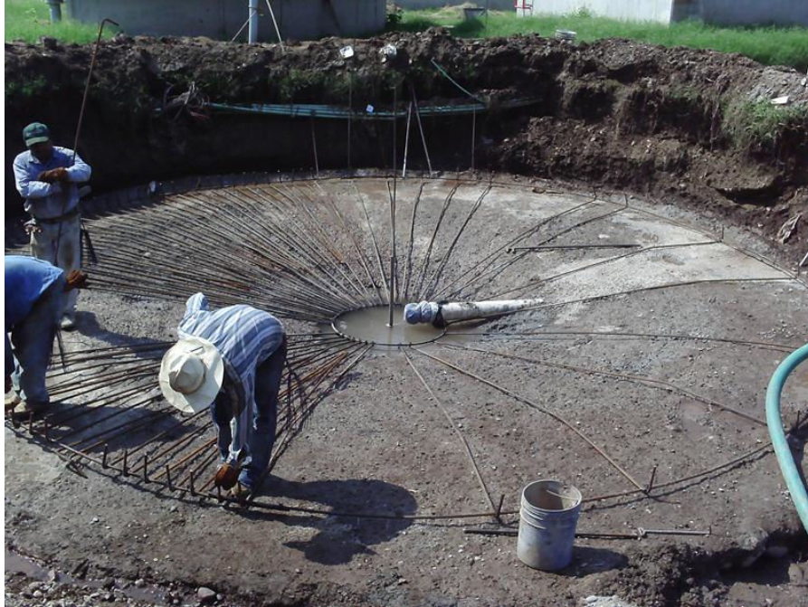
Obsérvese: plantilla terminada de concreto simple hecho en obra de f_c = 100 \text{ kg/cm}^2 , colocación de acero de refuerzo de f_y = 4200 \text{ kg/cm}^2 del # 5 con separación a cada 15 cm perimetral y radialmente en losa de cimentación en dos lechos para el espesor de lodos, tubería de salida de lodos de 102 mm (4") de diámetro hacia el digester de lodos.
