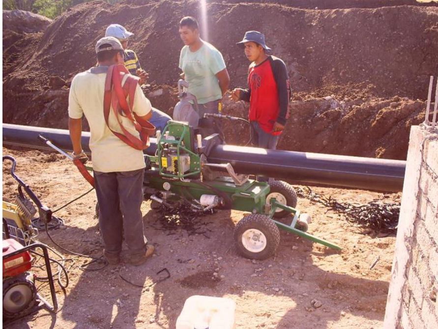
Obsérvese: equipo de termofusión para termofusionar tubería de polietileno de alta densidad RD 17 para alcantarillado de 152 mm (6") y 203 mm (8") de diámetro en interconexiones de unidades de proceso de la PTAR.
