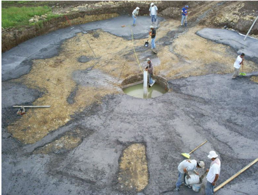
Obsérvese: colocación de plantilla de concreto simple de f'c = 100 \text{ kg/cm}^2 hecho en obra para recibir acero de refuerzo de la cimentación y desplante de muros del sedimentador secundario.
