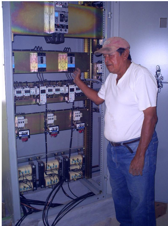
Obsérvese: Proceso de montaje de gabinete y conexión de los módulos del centro control de motores que contiene interruptores termomagnéticos, arrancadores magnéticos a tensión plena, relevadores, transformador seco, banco de capacitores y botoneras de arranque y paro de los equipos de la PTAR.
