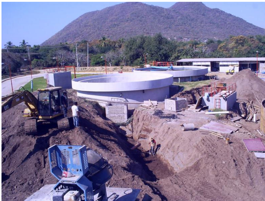
Obsérvese: Excavación en material denominado grava-arena con maquinaria para alojar tubería de polietileno de alta densidad de 203 mm (8") de diámetro para la interconexión de sedimentador primario a cárcamo de bombeo de lodos primarios.
