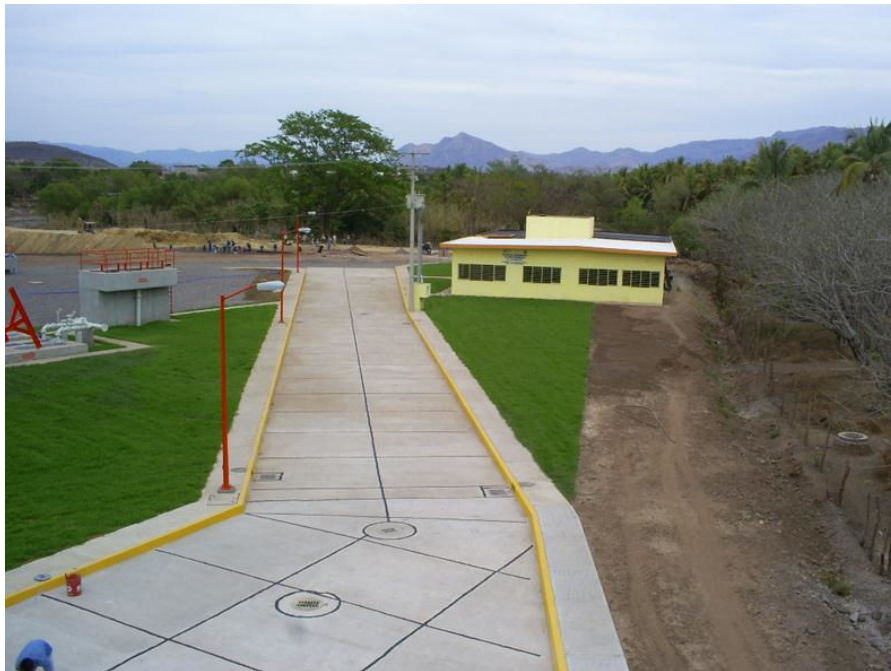
Obsérvese: Vista parcial de Jardinería, subestación eléctrica tipo poste de 150 KVA, nicho de medición e interruptor general, vialidad, banquetas y guarniciones, alumbrado exterior, cárcamo de bombeo de aguas crudas, caja distribuidora No 1 con barandales, pozos de visita de drenaje sanitario, rejillas de piso y banqueta del drenaje pluvial.
