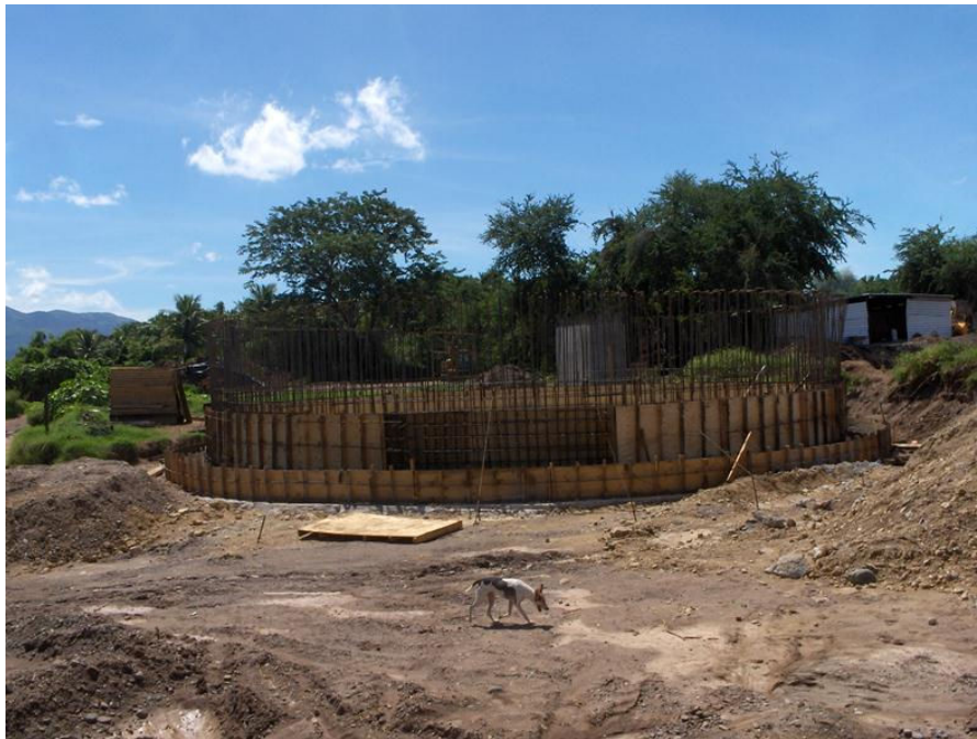
Obsérvase: Avance de la construcción del sedimentador secundario, cimbra perimetral de losa de cimentación y muros de la estructura, con acero de refuerzo f_y= 4200 \text{ kg/cm}^2 del # 6, los armados en la cimentación con separación 16 cm perimetralmente y a 21 cm radialmente, armado de muros en el sentido vertical a cada 20 cm y en sentido horizontal a cada 25 cm de separación.
