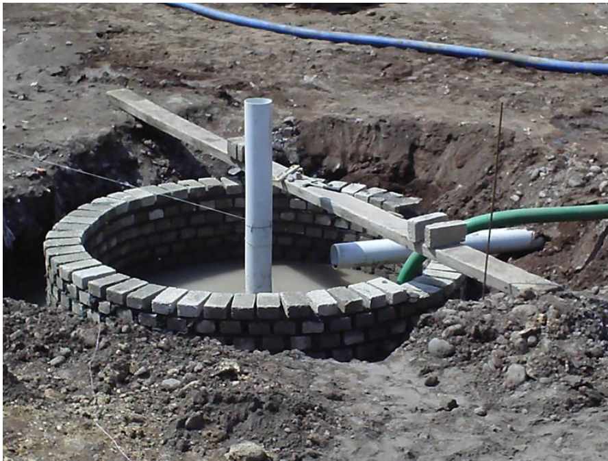
Obsérvese: construcción de muro de tabique para cimbra de tolva y tubería de pvc de 203 mm (8") de llegada del influente a la columna central y salida de lodos hacia el cárcamo de lodos primarios.
