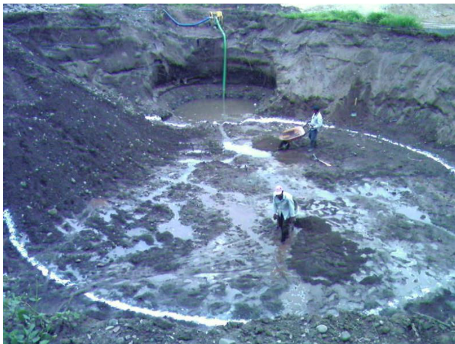
Obsérvese: Trazo para el desplante de la estructura de Filtro rociador, en la parte superior se encuentran trabajando el equipo de bombeo de achique de 102 mm (4") de diámetro de descarga para evitar la acumulación del agua freática en el área de trabajo
