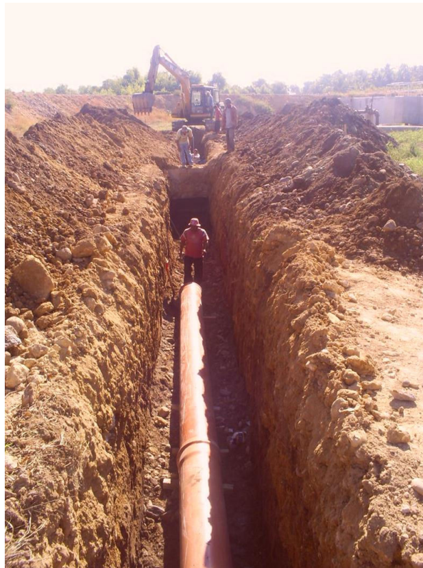
Obsérvese: Excavación de zanjas con maquinaria pesada para alojamiento e instalación de tubería de tubería de pvc serie DI alcantarillado de 350 mm (14") de diámetro para el drenaje pluvial de la PTAR.
