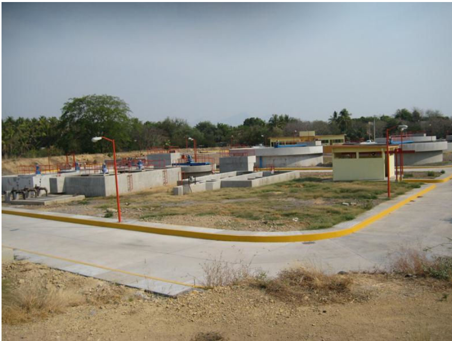
Obsérvese: Estructuras de proceso terminadas: Edificio de operación, sedimentadores secundarios, cajas distribuidoras, espesadores de lodos, digestores de lodos, tanque de contacto de cloro, alumbrado exterior, vialidad de concreto hidráulico, cárcamo de lodos digeridos y caseta de cloración de la PTAR.
