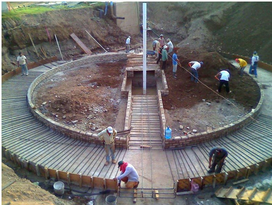
Obsérvese: Proceso constructivo del filtro rociador, muro de tabique para formar canales perimetrales y centrales, distribución de material producto de la excavación compactado al 60% de la prueba proctor estándar para formar plataformas de la losa de cimentación central, armado con varilla # 6, separación a cada 25 cm radialmente y a cada 20 cm en sentido perimetral en dos lechos, cimbra perimetral de la frontera del dentellón de la losa de cimentación.
