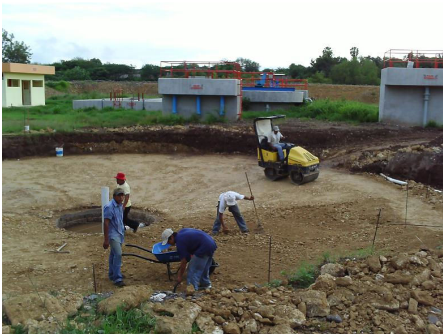
Obsérvese: Proceso constructivo de la capa compactada con material de banco, tepetate al 95% de la prueba proctor estándar, realizando acciones de papeo, compactación con rodillo vibratorio y afine de los taludes con herramienta menor.
