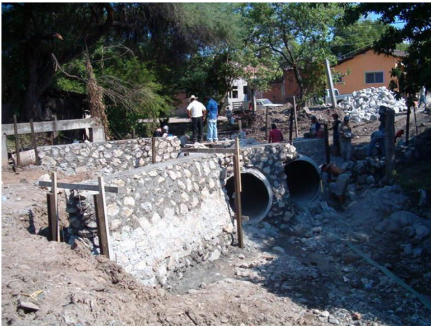
Obsérvese: Avance de la construcción del puente de mampostería de piedra braza sobre el arroyo sin nombre para complementar la capacidad de gasto que circula por dos tuberías de concreto reforzado de 1.22 m de diámetro para ingresar a los terrenos donde se construyó la planta de tratamiento de aguas residuales.
