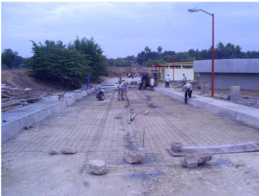
Obsérvese: Colocación de malla electrosoldada 6-6-10/10 de f_y = 50 \text{ kg/mm}^2 en construcción de vialidad para suplir los efectos de agrietamiento por temperatura en la losa de concreto de 15 cm de espesor de f'_c = 200 \text{ kg/cm}^2 y colocación de cimbra tubular en la frontera central para seccionar las dimensiones de los cuadros que forman las losas de transito de la vialidad.
