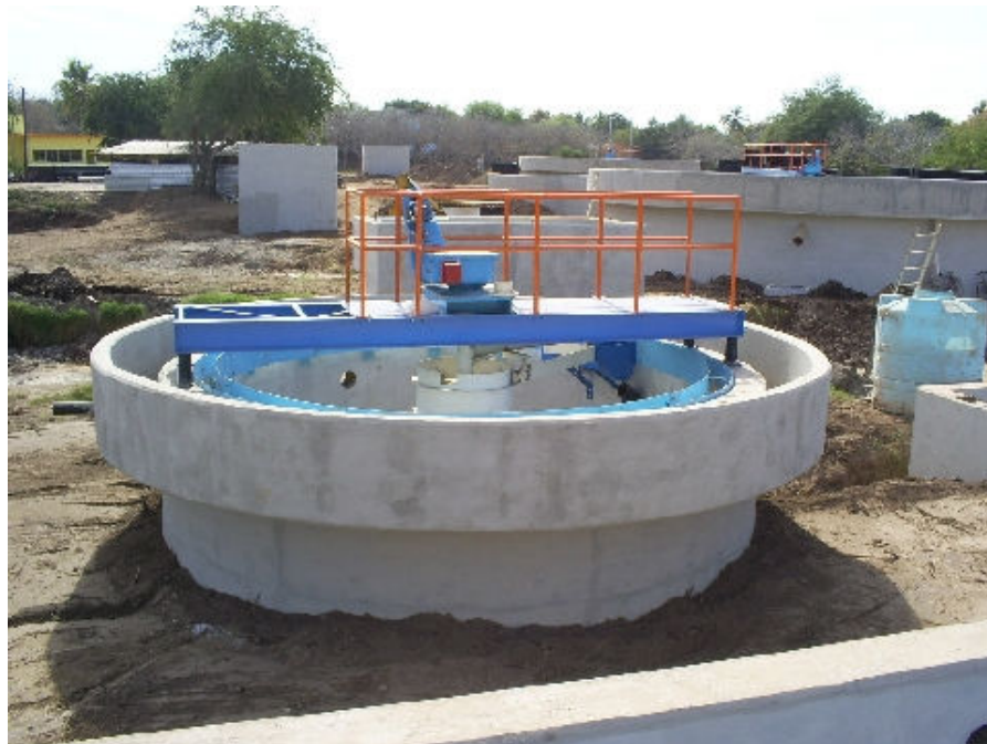
Obsérvese: estructura de espesador de lodos de concreto armado terminada, pasillo de operación con barandal y montaje del mecanismo del motoreductor que permite que el sistema gire perimetralmente sobre su eje central para disminuir la carga líquida de la mezcla hacia su paso al digestor de lodos.
