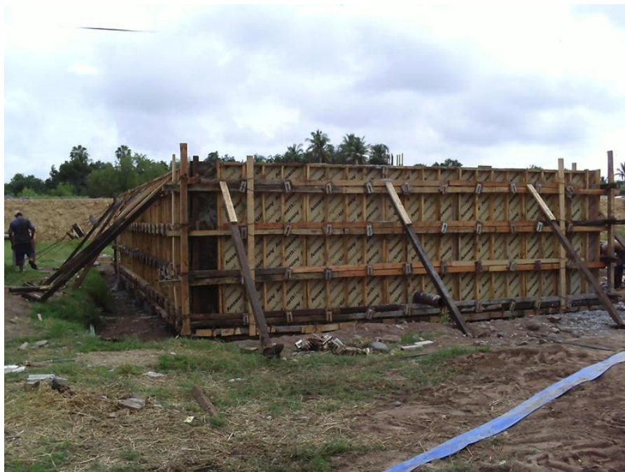
Obsérvese: cimbra de contacto interior y exterior con madera con triplay de 19 mm de espesor en muros a una altura de 2.44 m con respecto al nivel de desplante rigidizada con barotes en el sentido vertical y en el sentido horizontal con moños y polines con dimensiones de 0.10 \times 0.10 \times 3.05 \text{ m} en el digestor de lodos.
