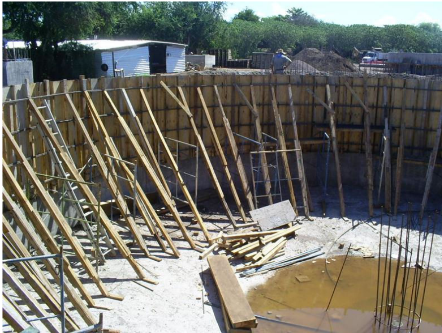
Obsérvese: Avance de la estructura del sedimentador secundario donde se esta realizando el cimbrado interior con madera de triplay de 19 mm de espesor, con obra falsa y los andamios utilizados durante la ejecución de los trabajos para la conclusión de los muros y el canal perimetral de la estructura.
