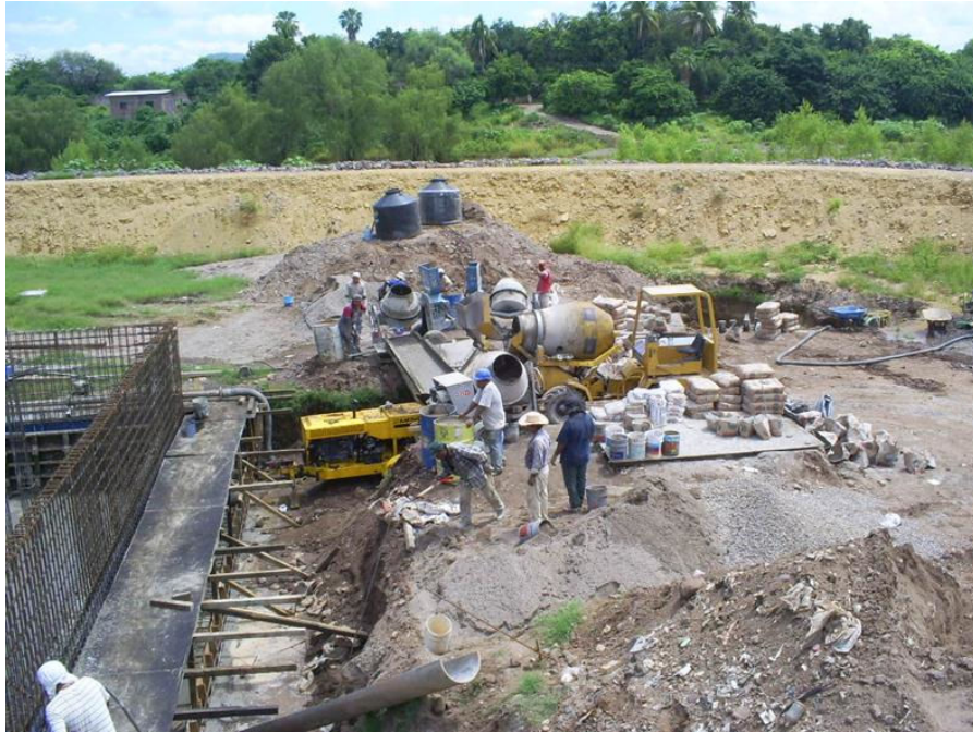
Obsérvese: Procedimiento para fabricación y colado de concreto hecho en obra con impermeabilizante integral de f'c= 250 \text{ kg/cm}^2 , el equipo empleado para la fabricación fueron: tres revolvedoras de 1 saco, hormigonera autosificante de 1.00 \text{ m}^3 de capacidad, bomba de concreto, canalón habilitado en obra de madera para alimentación a la tolva de la bomba de concreto, vibrador de inmersión y motobomba de 76 mm (3") de descarga para alimentación de agua a los tinacos de 1,100 lts de capacidad.
