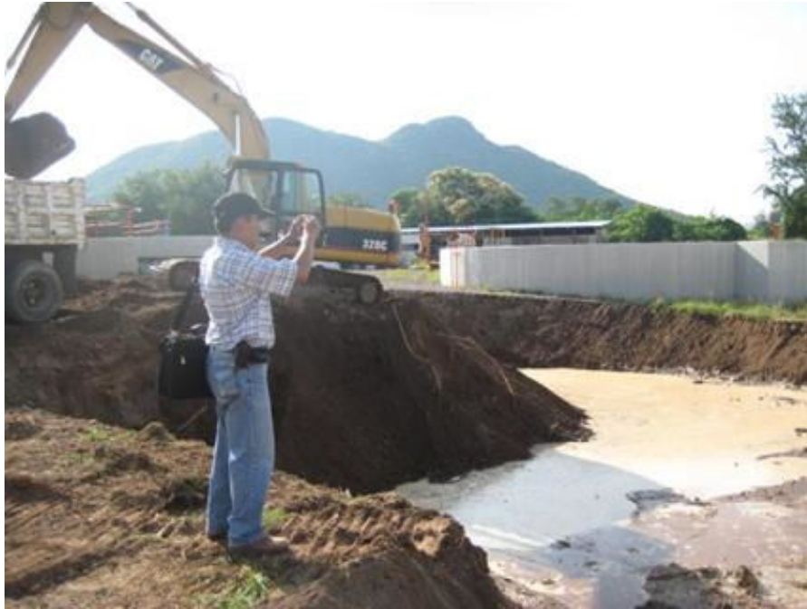
Obsérvese: Excavación del material denominado grava-arena a cielo abierto con maquinaria pesada en presencia de agua para el desplante de la estructura de Filtro rociador así como la carga del material producto de la excavación para su retiro fuera de la obra.
