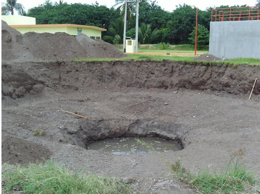
Obsérvese: excavación en material denominado grava-arena para desplante de sedimentador primario con su respectiva tolva donde se aprecia el agua del nivel freático.
