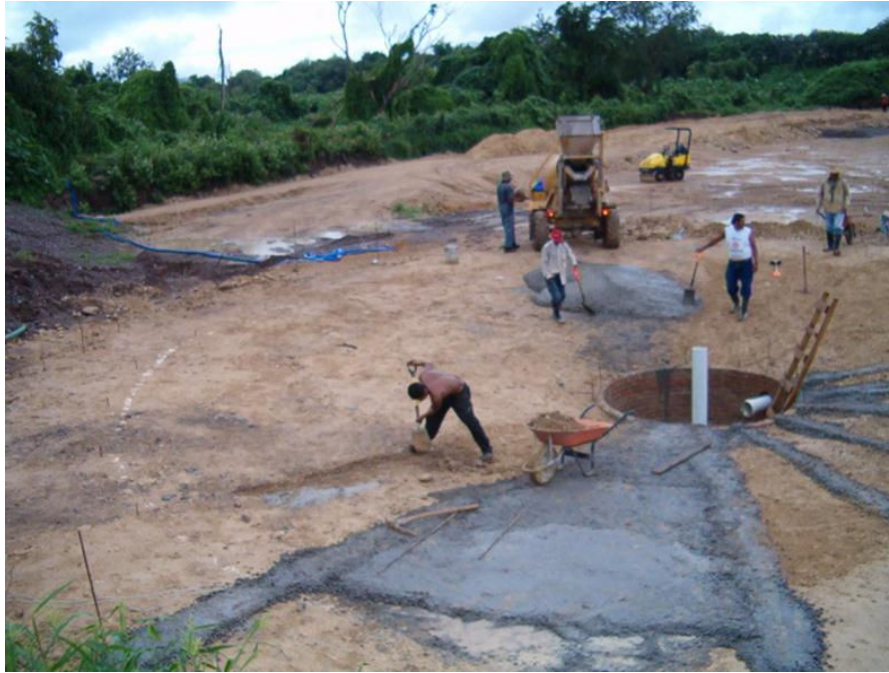
Obsérvase: construcción de plantilla de concreto simple f'c= 100 \text{ kg/cm}^2 desplantada sobre capa compactada con material de banco tepetate al 95% de la prueba proctor estándar, al centro se aprecia muro de tabique rojo para cimbra de tolva y tubería de pvc de 203 mm (8") de llegada del influente a la columna central y salida de lodos hacia el cárcamo de lodos primarios.
