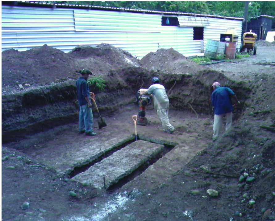
Obsérvese: Compactación del terreno natural al 60% de la prueba proctor estándar, también se aprecia la excavación para el desplante del dentellón de la cimentación de la caja distribidora No 2
