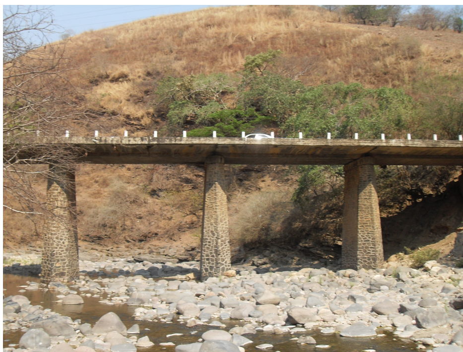
Figura 5.2: Puente San Felipe vista general
