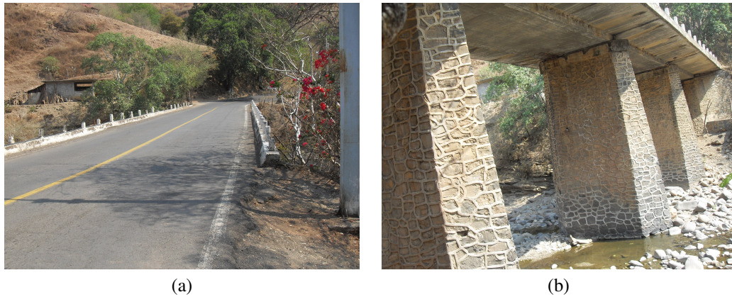
Figura 5.1: (a) Vista superior del puente. y (b) Vista inferior del puente.
