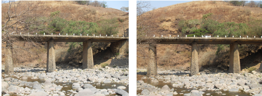
Figura 5.2: Vista lateral del puente.
