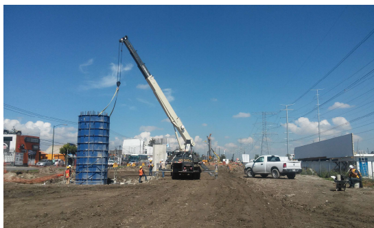
Figura 3.3.6 Cimbra de columna colocada
