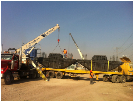
Figura 3.4.1 Llegada de armado de capiteles
