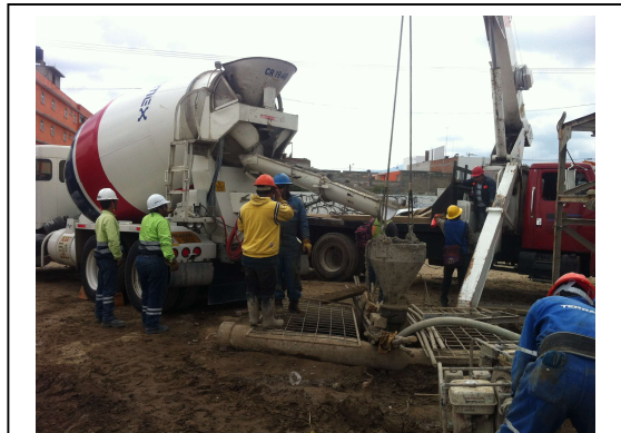
Figura 3.1.7 Colado de pila
