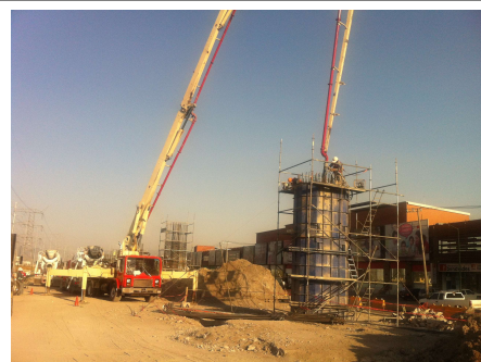
Figura 3.3.7 Colado de columna
