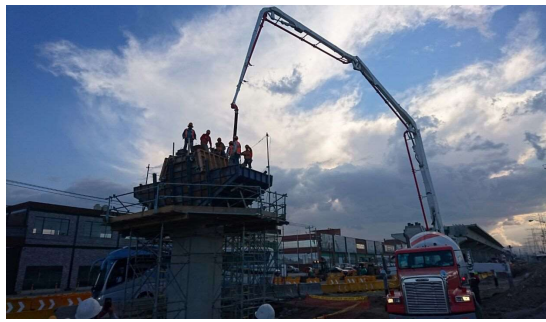
Figura 3.4.5 Colado de capitel
