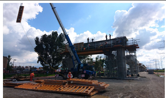
Figura 3.4.10 Cimbrado del pórtico
