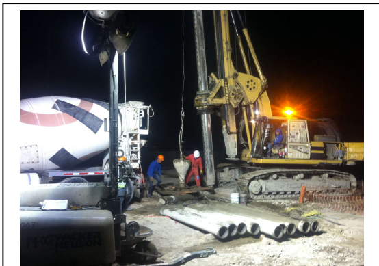
Figura 3.1.8 Colado de pila (2)
