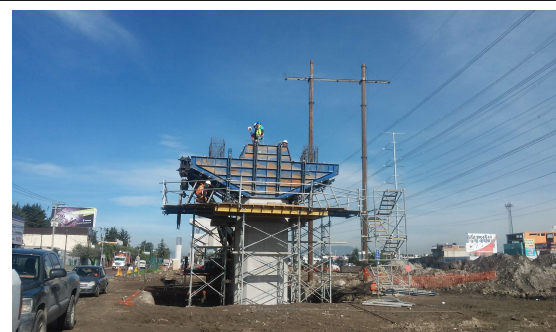
Figura 3.4.4 Colocación de segunda etapa de cimbra
