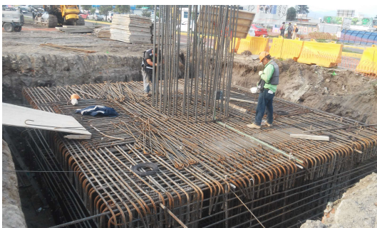
Figura 3.2.7 Armado de zapata
