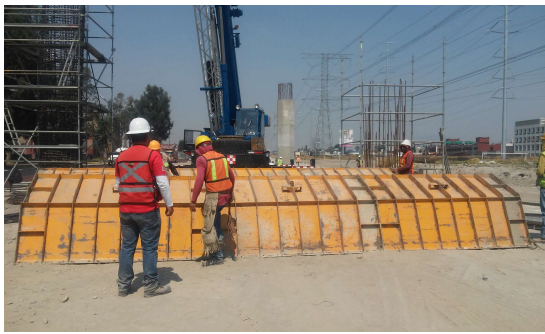
Figura 3.3.4 Cimbra de columna
