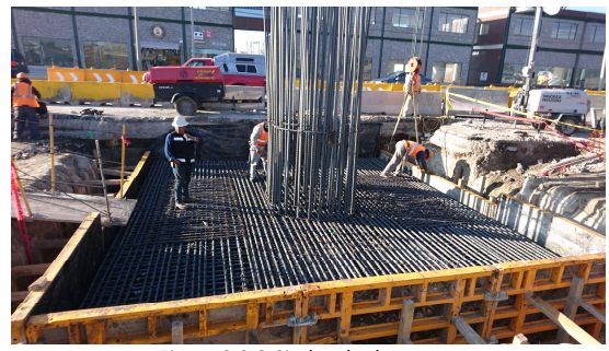
Figura 3.2.8 Cimbrado de zapata
