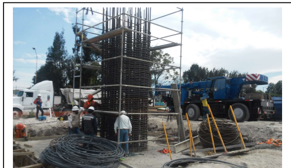
Figura 3.3.3 Armado de columna.
