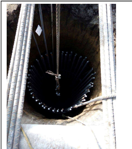
Figura 3.1.6 Acero de pila colocado y centrado
