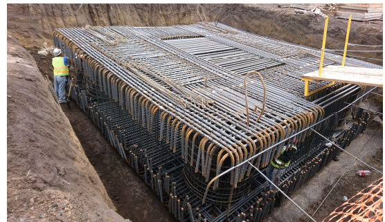
Figura 3.2.6 Armado la zapata
