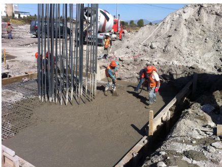
Figura 3.2.9 Colado de zapata
