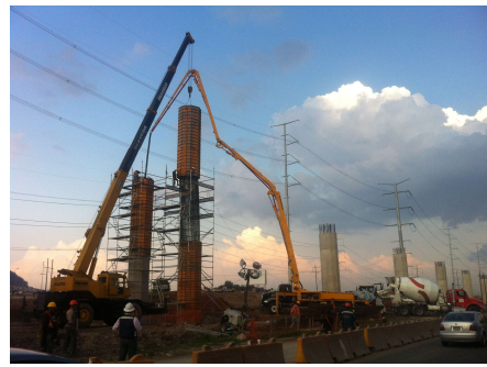
Figura 3.6.5 Cimbrado de columna
