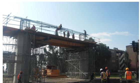
Figura 3.4.8 Inicio de armado de pórtico
