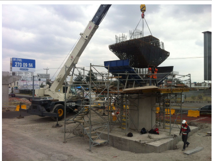
Figura 3.4.3 Colocación del armado de capitel
