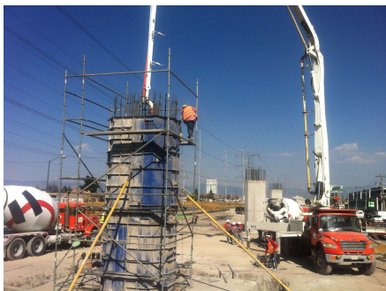
Figura 3.3.8 Colado de columna (2)
