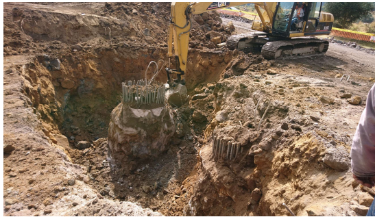
Figura 3.2.3 Excavación de zapata
