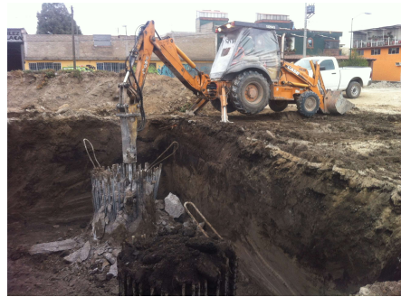
Figura 3.2.4 Descabece de pilas
