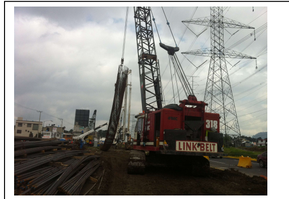
Figura 3.1.5 Izamiento de acero de pila
