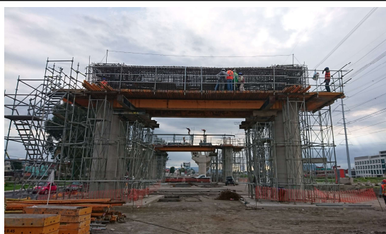
Figura 3.4.9 Armado de pórtico
