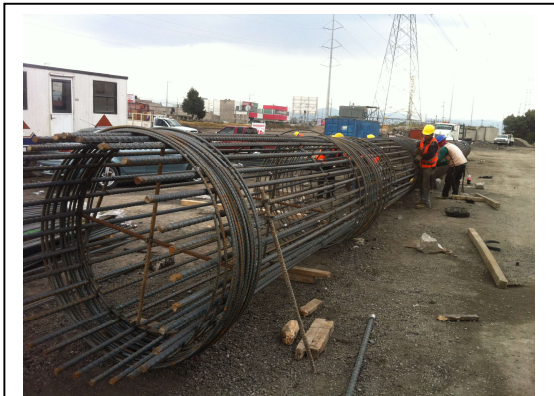
Figura 3.1.4 Armado de pila
