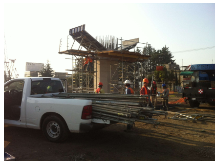
Figura 3.4.2 Colocación de primera etapa de cimbra
