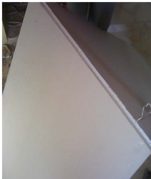
Figura 30. Armado de la tablaroca.
