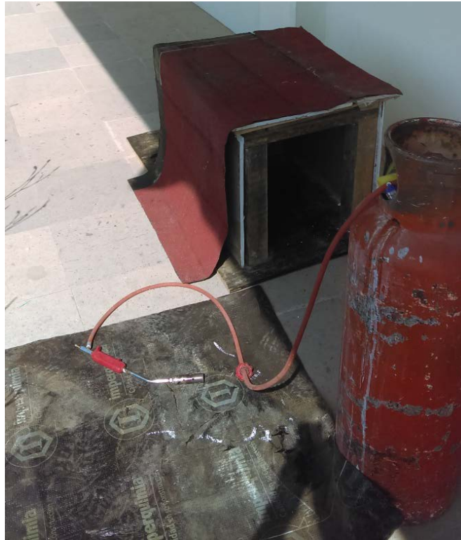
Figura 46. El proceso de pegar el rollo asfáltico es el mismo que en el primer prototipo.
