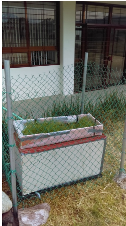
Figura 37. Maqueta con malla instalada.
