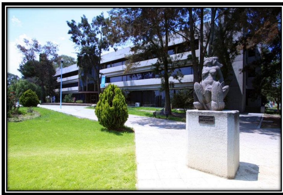
ILUSTRACIÓN 6. COLPOS EDIFICIO PRINCIPAL
